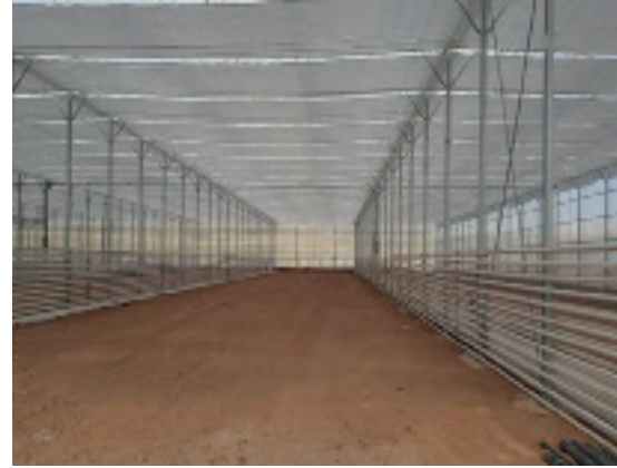
Görsel 2.66: Yan duvar borulu ısıtma sistemi
