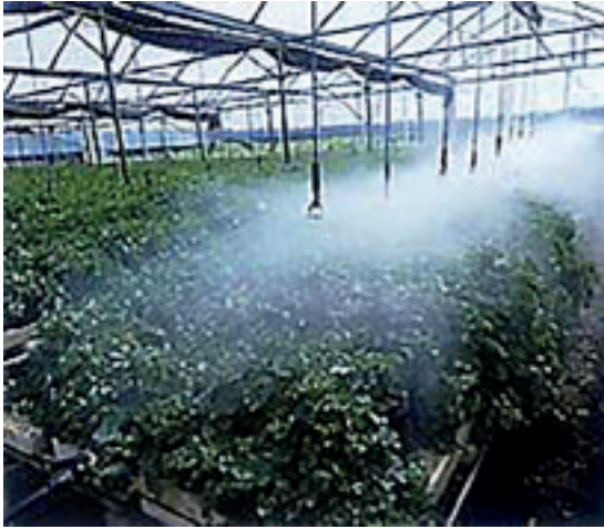
Görsel 2.73: Üstten sabit yağmurlama sulama sistemi
