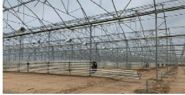
Görsel 2.33: Metal yapı malzemeleri ile kurulan sera
