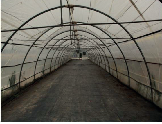
Görsel 1.33: Yüksek tünelin iskelet sisteminin içten görünüşü
