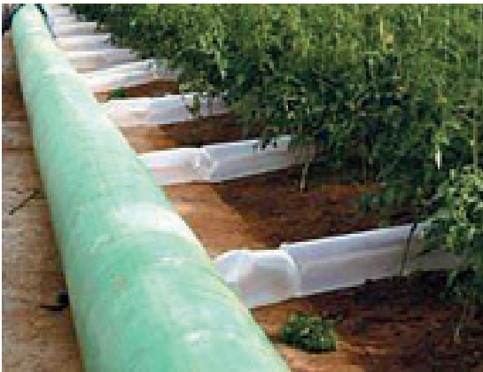
Görsel 2.70: Sıcak hava ile ısıtma sistemi
