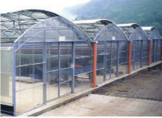
Görsel 2.42: Polikarbon ile yapılmış sera
