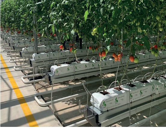
Görsel 2.68: Tezgâh altı borulu ısıtma sistemi
