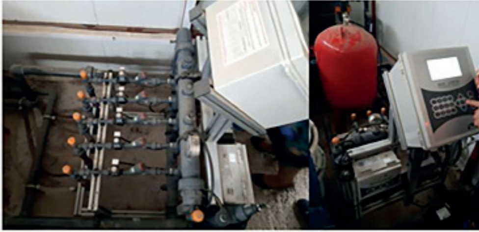
Görsel 2.117: Kapalı sistem otomatik kontrol ünitesi
