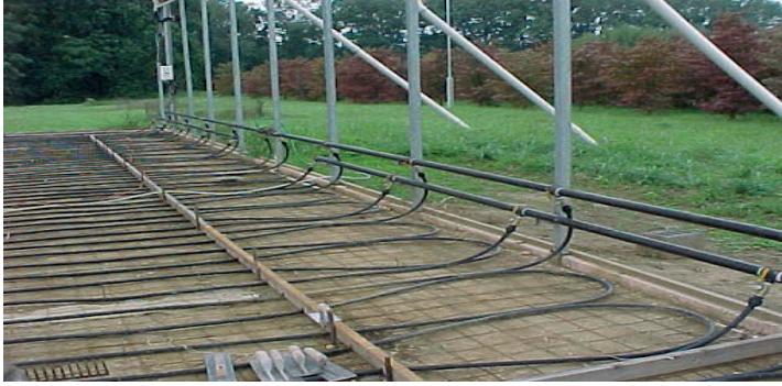
Görsel 2.61: Jeotermal kaynak ile sera toprağının ısıtılması
