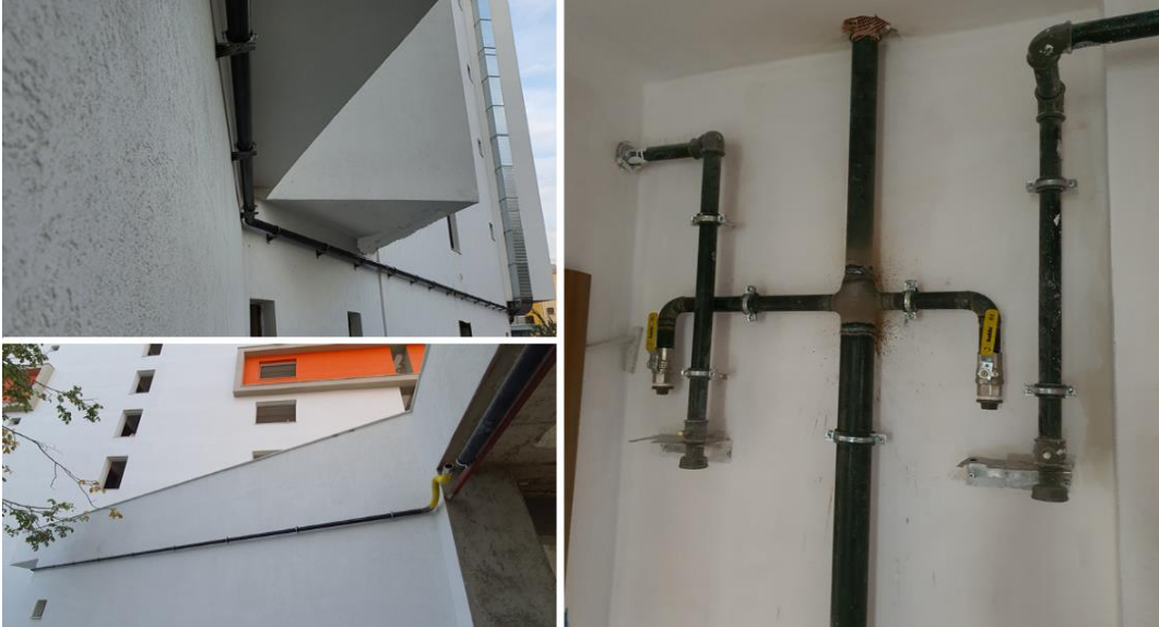
Görsel 3.15: Doğal gaz borularının kelepçeler ile yapı elemanlarına sabitlenmesi
