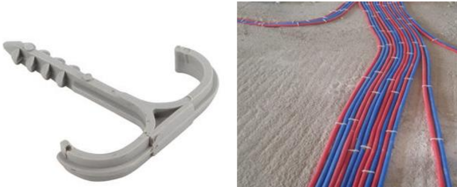
Görsel 9.3: Kılçık kelepçe ve uygulaması
