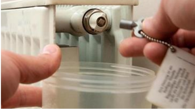
Görsel 9.25: Radyatör üzerinden hava alma vidası
