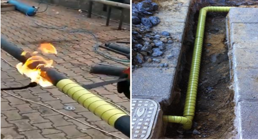
Görsel 2.16: Çelik borularda polietilen sargı
