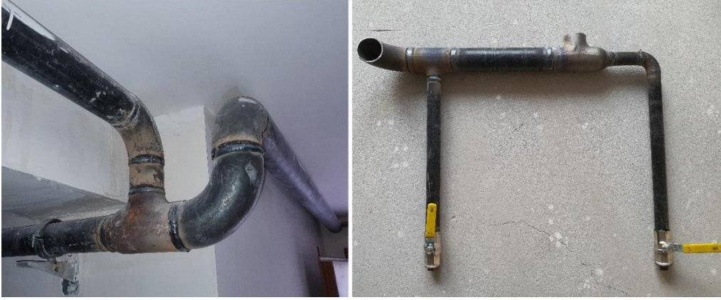
Görsel 2.6: Kaynaklı ve dişli birleştirme
