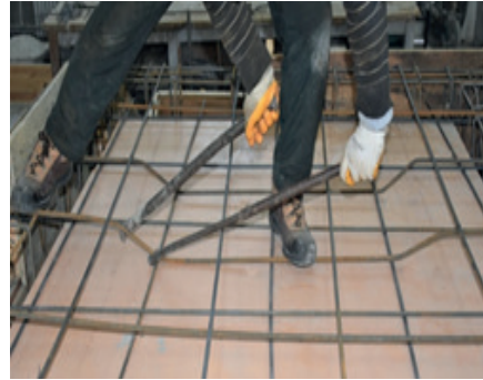
Resim 15.4: Döşeme pilyelerinin bükülmesi
