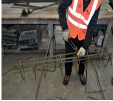
Resim 13.3: Etriyelerin bağlanması Resim 13.4: Etriyelerin bağlanması
