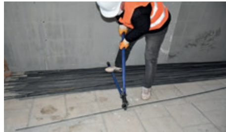
Resim 11.20: Markalanmış demir çubuk kesme
