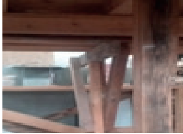
Resim 8.6: Kalıp çaprazlarının sökümü Resim 8.7: Yatay takviyelerin sökümü
