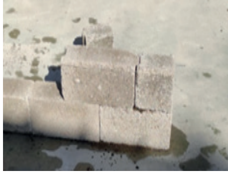
Resim 19.6: İkinci sıra uygulamasına yarım blok ile başlanması
