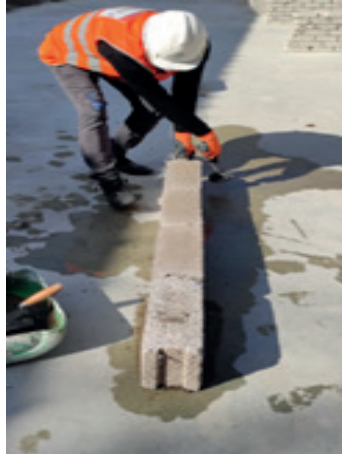
Resim 19.2: İlk sıra uygulamasının yapılması
