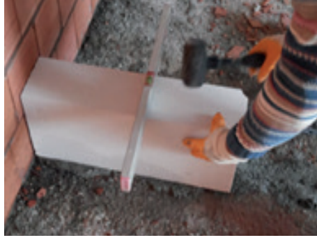
Resim 19.10: Gazbeton blokların yerleştirilmesi
