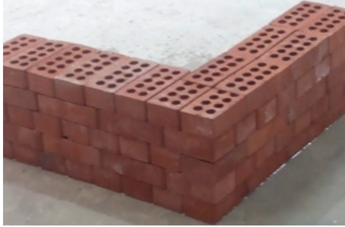
Resim 18.3: Köşede dik birleşen duvar perspektif görünüşü
