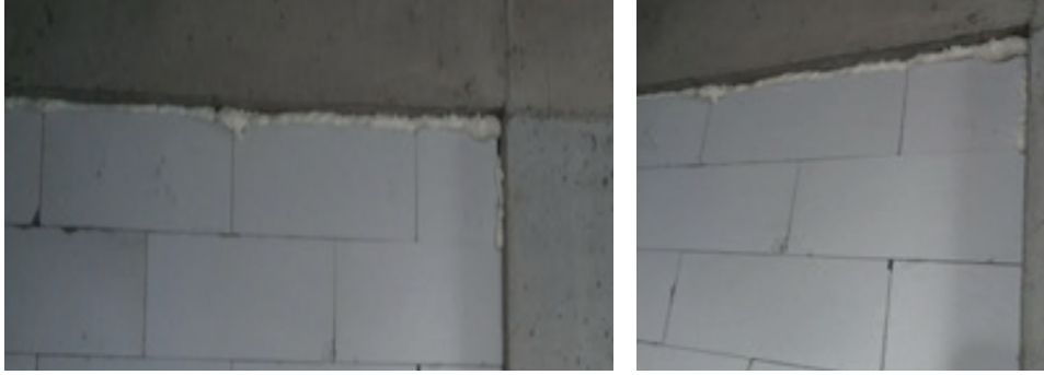
Resim 19.16: Duvar ile kiriş arasının dolgu malzemesi ile doldurulması
