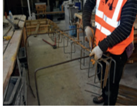
Resim 16.4: Etriye aralıklarını markalama
