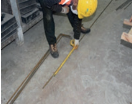
Resim 11.25: Pilye demir çubuğu markalama Resim 11.26: Pilye demir çubuğu kesme
