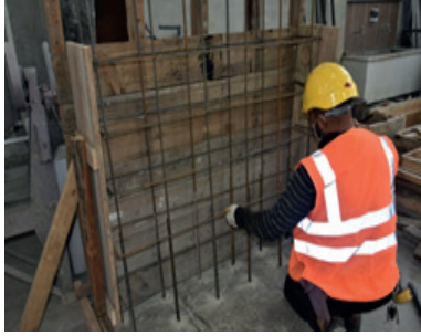
Resim 13.9: Tevzi demirlerinin bağlanması Resim 13.10: Çiroz demirlerinin bağlanması
