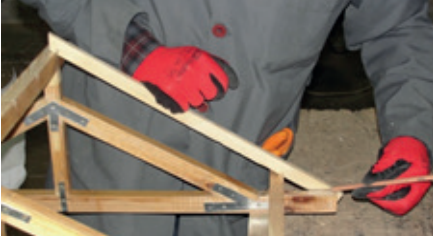
Resim 10.64: Mertek damlalık alıştırması
