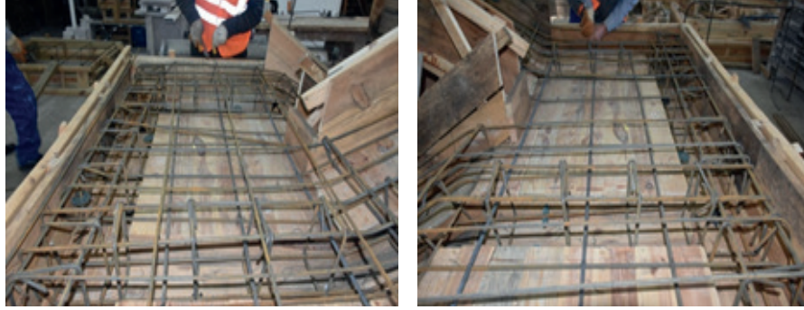
Resim 16.15: b) Bağlama yerleri ve proje uygunluğunu kontrol etme
