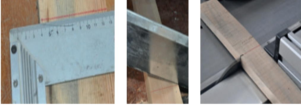
Resim 2.2: Kalıp elemanlarının markalanıp kesilmesi
