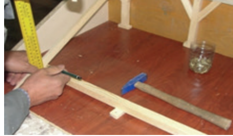
Resim 10.11: Makas merteği alıştırma
