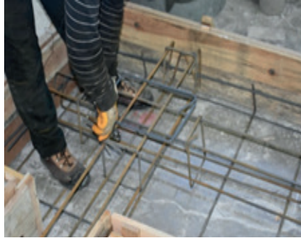
Resim 14.7: Deprem hatılı kolon filizini sarmalıdır.
