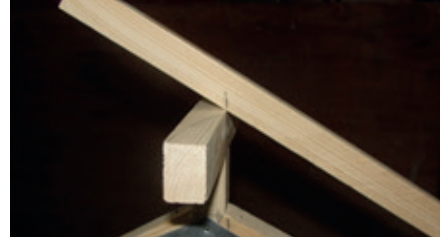
Resim 10.51: Makas mertekleri markalama
