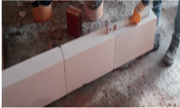
Resim 19.11: İlk sıra yataylık kontrollerinin yapılması
