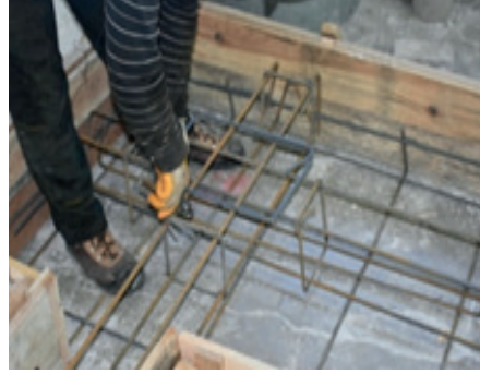
Resim 14.19: Hatıl etriyesi ve kolon filiz etriyesi bağlama
