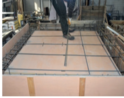
Resim 15.2: Döşeme donatılarının yerleştirilmesi
