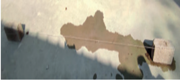
Resim 19.1: Köşe bloklarının yerleştirilmesi ve ip çekilmesi
