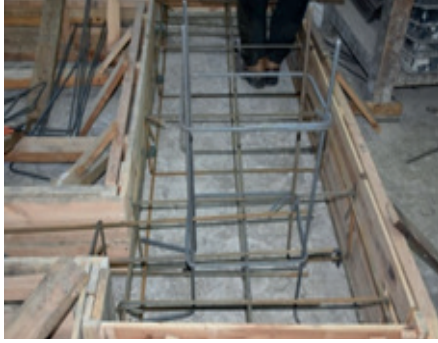
Resim 14.20: Kolon filizlerini bağlama
