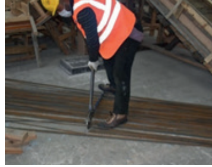
Resim 11.25: Pilye demir çubuğu markalama Resim 11.26: Pilye demir çubuğu kesme
