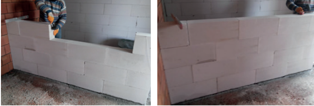
Resim 19.14: Diğer sıraların duvar örgü kurallarına göre tamamlanması
