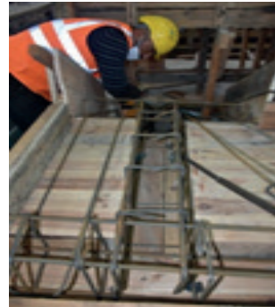
Resim 16.6: Kirişleri kalıba yerleştirme
