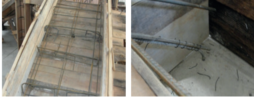
Resim 16.27: Merdiven demirlerinin bağlarını kontrol etme
