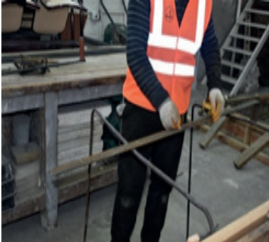
Resim 13.1: Etriye aralıklarının markalanması
