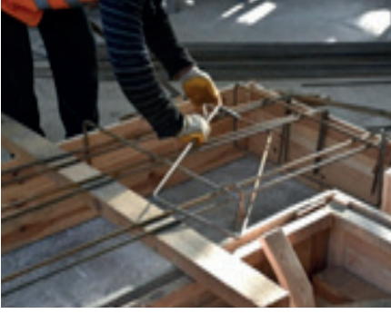
Resim 14.14: Kalıp içine demirleri serme
