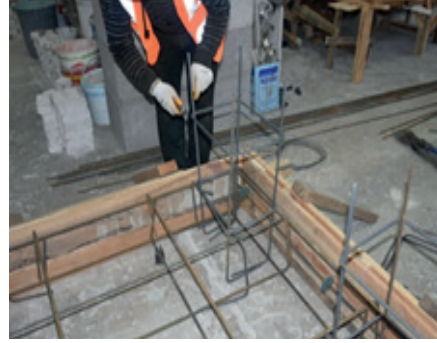
Resim 14.31: Kolon filizine ikinci etriyeyi bağlama
