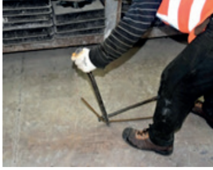
Resim 11.27: Pilye demir çubuğu bükme
