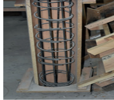
Resim 13.15: Bağlanmış fret donatısı
