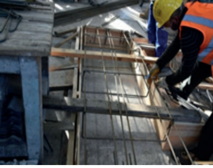
Resim 14.16: Demirleri markalı yerden bağlama
