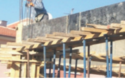
Resim 8.5: a) Kalıp kanat sökümü
