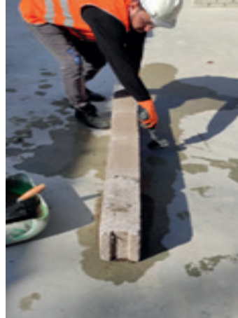
Resim 19.2: İlk sıra uygulamasının yapılması
