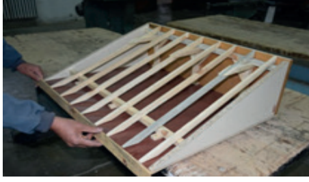
Resim 10.23: Çatı alın tahtası çakma Resim 10.24: Çatı kaplama tahtası çakma
