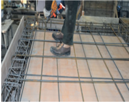
Resim 15.3: Döşeme donatılarının bağlanması
