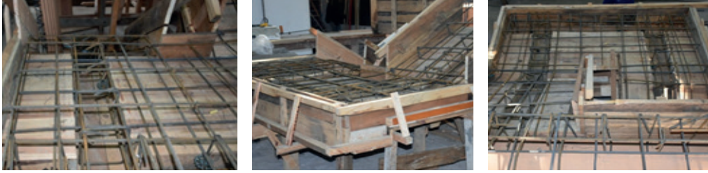
Resim 16.15: a) Bağlama yerleri ve proje uygunluğunu kontrol etme
