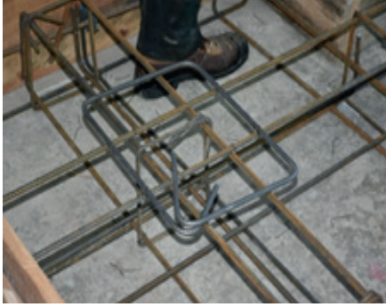
Resim 14.8: Kolon filizleri proje aksında bağlanmalı Resim 14.9: Kolon filiz ve etriyeleri
