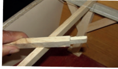
Resim 10.16: Kuşığı aşığa alıştırma
