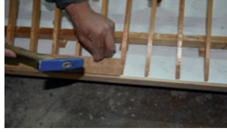
Resim 10.23: Çatı alın tahtası çakma Resim 10.24: Çatı kaplama tahtası çakma
