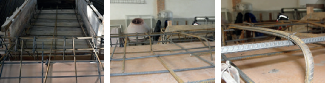
Resim 16.25: Boyuna üst demirleri bağlama
