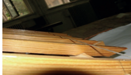
Resim 10.69: Merteklerin ip kotuna getirilmesi
