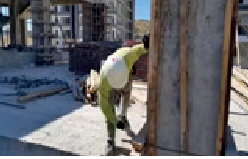
Resim 8.3: Tayrotların sökümü
