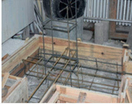
Resim 14.10: T1 temel donatı kontrolü
