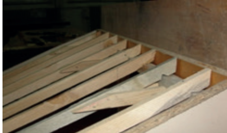
Resim 10.22: Mertekleri proje ölçüsünde çakma
