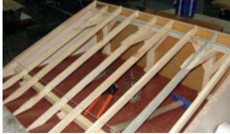
Resim 10.20: İp kotunda mertekler çakma
