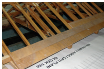
Resim 10.71: Tahta ekinin merteğin ortasına gelmesi
