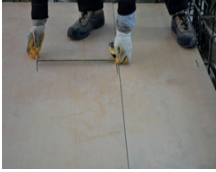
Resim 15.1: Döşeme kalıbı üzerine donatı yerlerinin işaretlenmesi
