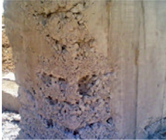
Resim 7.2: Betonda ayrışma
