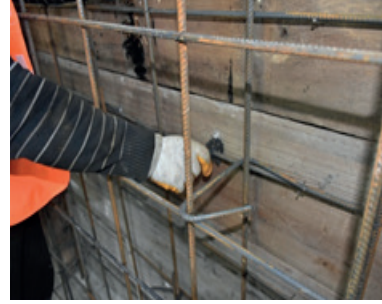
Resim 13.9: Tevzi demirlerinin bağlanması Resim 13.10: Çiroz demirlerinin bağlanması
