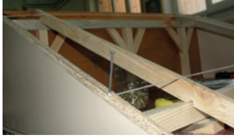
Resim 10.14: Mertekleri ip ile kota getirme
