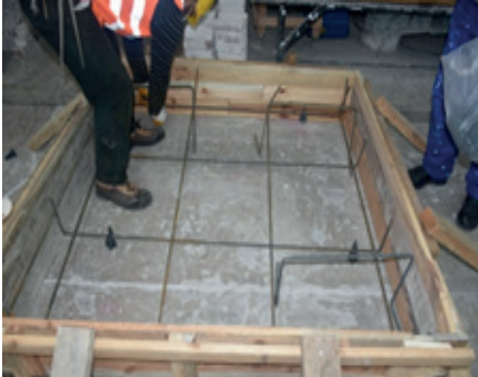
Resim 14.26: Üst demir için sehpayı kullanma
