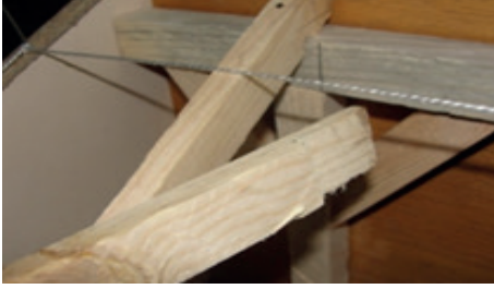
Resim 10.15: Kuşığı dikmeye alıştırma
