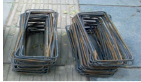
Resim 11.24: Yapımı tamamlanmış etriye donatısı
