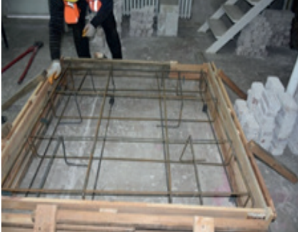
Resim 14.28: Üst demirleri bağlama
