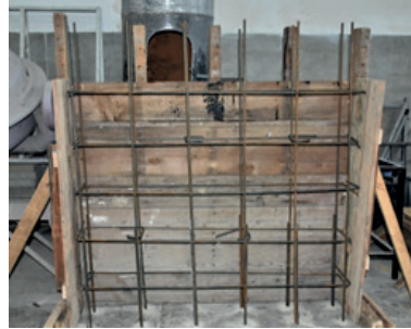
Resim 13.11: Tamamlanmış perde donatısı
