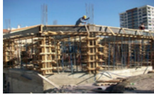
Resim 8.5: b) Kalıp kanat sökümü
