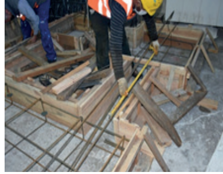
Resim 14.6: B.K. etriye yerlerini markalama
