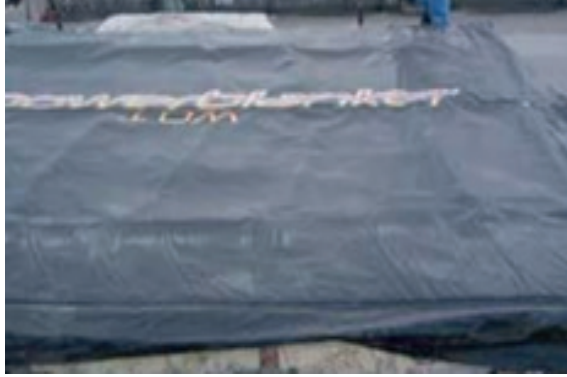
Resim 7.3: Elektrikli ısıtma battaniyesi ile betonun korunması
