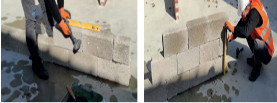
Resim 19.8: Şakul ve su terazisi ile yatay ve düşeylik kontrolü
