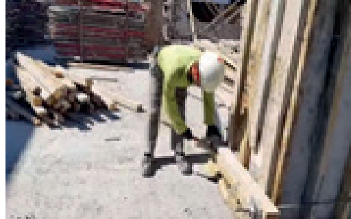
Resim 8.2: Tayrotların sökümü
