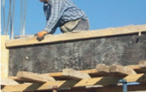
Resim 8.1: Dış kanat takviye sökümü
