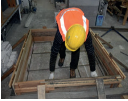
Resim 14.22: Kalıp içinde markalama
