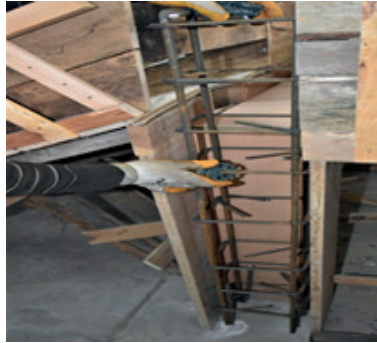
Resim 13.6: Kolon donatısının kalıba yerleştirilmesi
