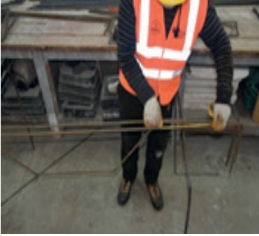
Resim 12.3: Etriye aralıklarının markalanması
