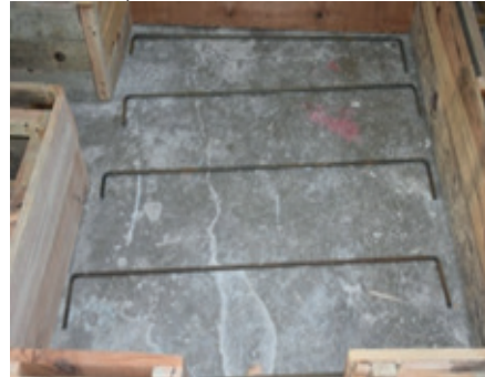
Resim 14.2: Demirlerin kalıba serilmesi
