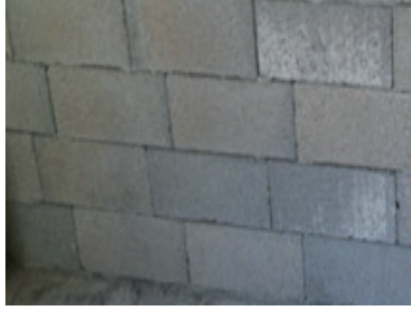
Resim 19.7: Yatay ve düşey derzlerin uygun kalınlıkta örülmesi
