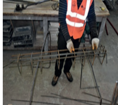
Resim 13.2: Etriyelerin dizilmesi
