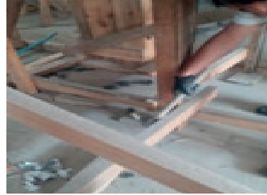
Resim 8.6: Kalıp çaprazlarının sökümü Resim 8.7: Yatay takviyelerin sökümü
