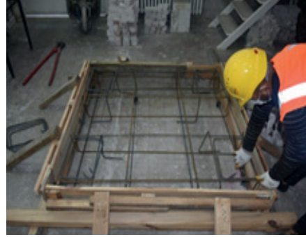
Resim 14.29: Kolon filiz yerlerini markalama
