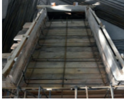
Resim 16.23: Alt ve üst tevzileri serme
