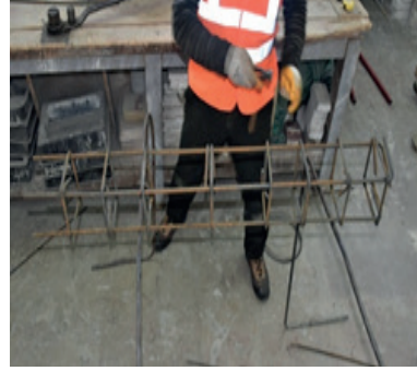
Resim 13.3: Etriyelerin bağlanması Resim 13.4: Etriyelerin bağlanması
