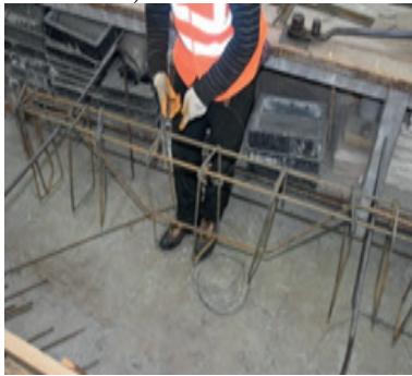
Resim 12.5: Etriye ve pilye demirinin bağlanması
