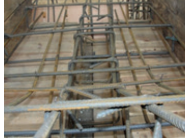
Resim 16.12: a) Tevzileri bağlama
