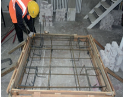
Resim 14.30: Kolon filizi bağlama
