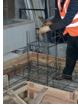
Resim 14.8: Kolon filizleri proje aksında bağlanmalı Resim 14.9: Kolon filiz ve etriyeleri
