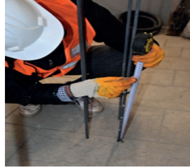
Resim 13.13: Fret aralığı markalama
