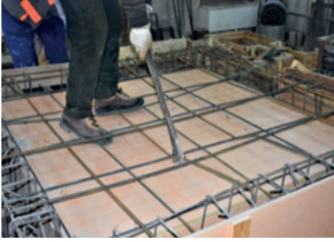
Resim 15.5: Döşeme pilye bükümü
