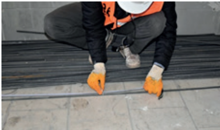
Resim 11.19: Demir çubuk markalama
