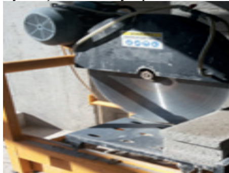
Resim 19.5: Bims blokların spiralle kesilmesi
