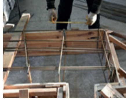
Resim 14.15: Bağlama yerlerinin markalanması
