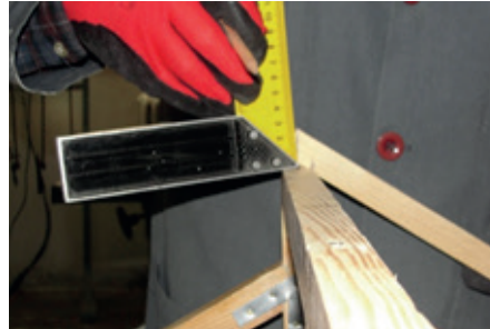
Resim 10.63: Mertek bitimini markalama
