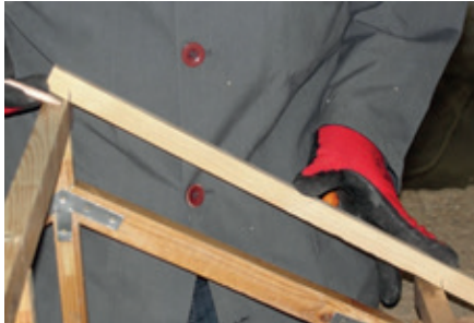
Resim 10.62: Mertek alıştırma
