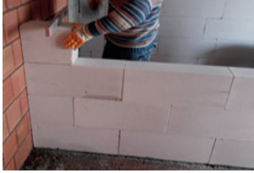
Resim 19.15: Duvarda su terazisi ile kontrollerin yapılması
