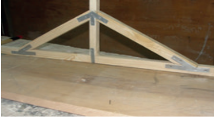
Resim 10.50: Makasın metal bağlantılarını tamamlama
