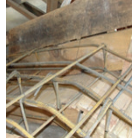
Resim 16.12: b) Tevzileri bağlama
