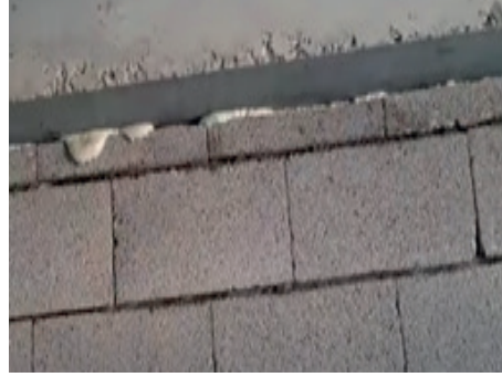
Resim 19.9: Duvar ile kiriş bağlantısının poliüretan köpük ile doldurulması
