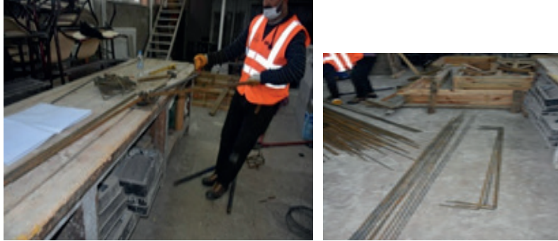
Resim 14.13: Markalama yapma ve bükme
