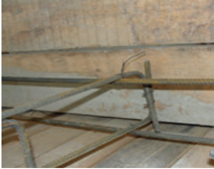
Resim 16.24: Alt ve üst tevzileri bağlama
