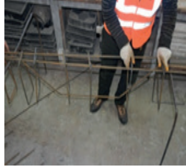
Resim 12.4: Etriyelerin yerlerine dizilmesi
