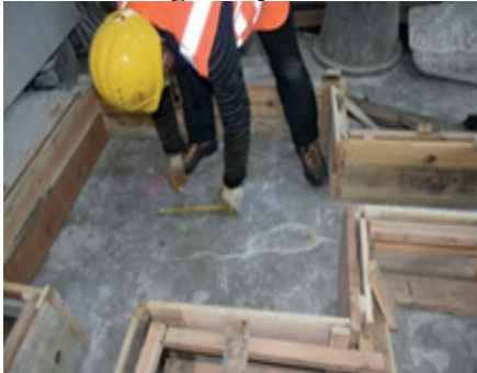
Resim 14.1: Kalıp içine çizim
