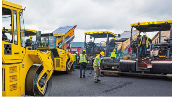
Görsel 9.8: Serme ve sıkıştırma işlerinin birlikte yürütülmesi
