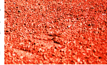
Görsel 5.10: Renkli asfalt
