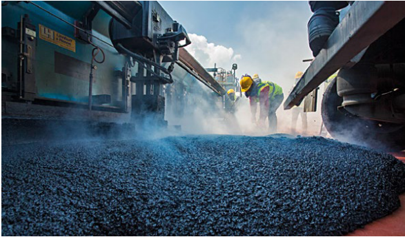
Görsel 9.9: Sıcak bitümlü karışım serme işlemi
