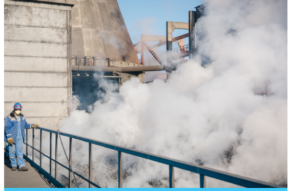
Görsel 3.5: Basınçlı su ile söndürme ünitesi
