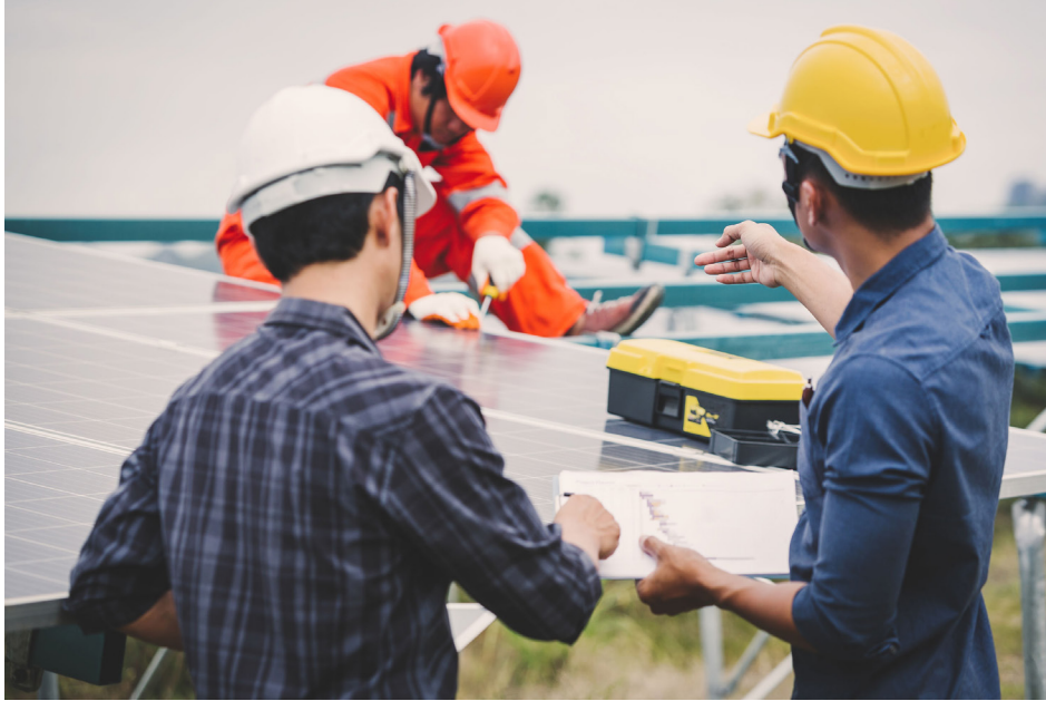
Görsel 2.2: Güneş enerjisi (fotovoltaik) proje kontrolü
