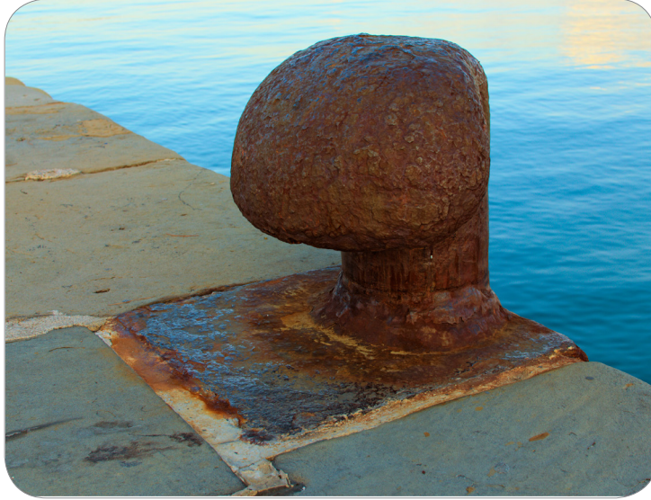
Görsel 2.2: İskele babası üzerindeki homojen korozyon
