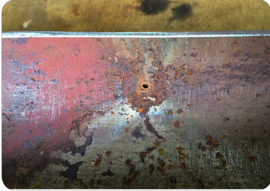
Görsel 2.4: Çukurcuk korozyon
