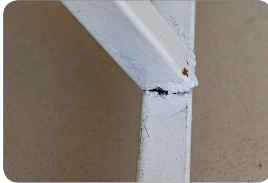
Görsel 3.3: Çatlak süreksizliği
