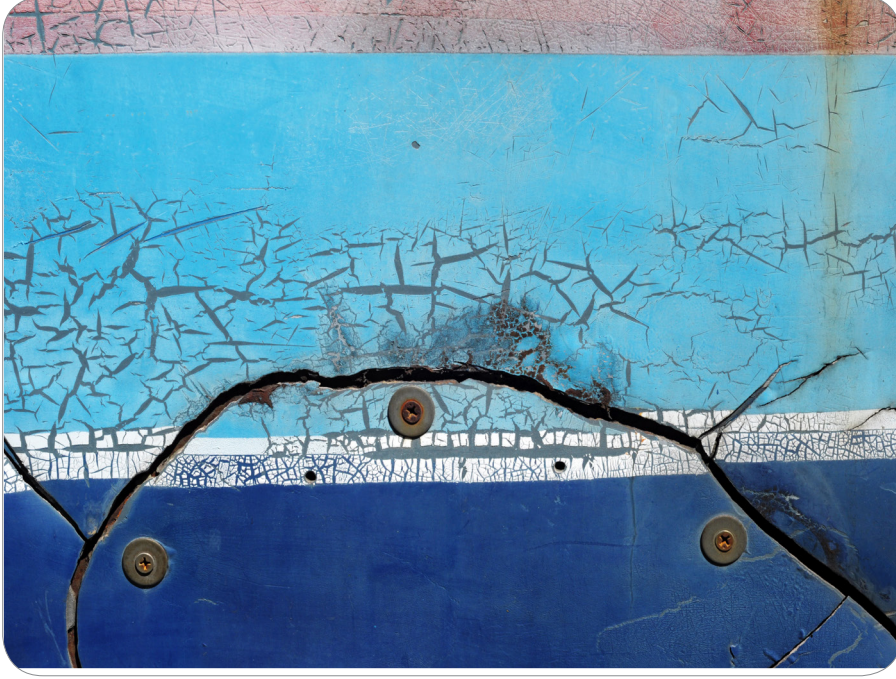
Görsel 2.6: İpliğimsi korozyon
