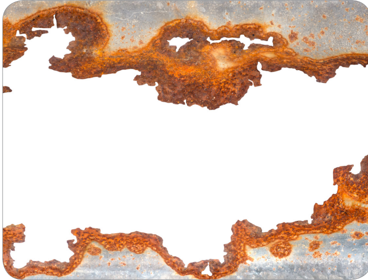
Görsel 2.3: Galvanik korozyon
