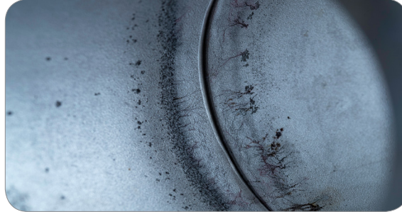
Görsel 2.9: Gerilmeli korozyon
