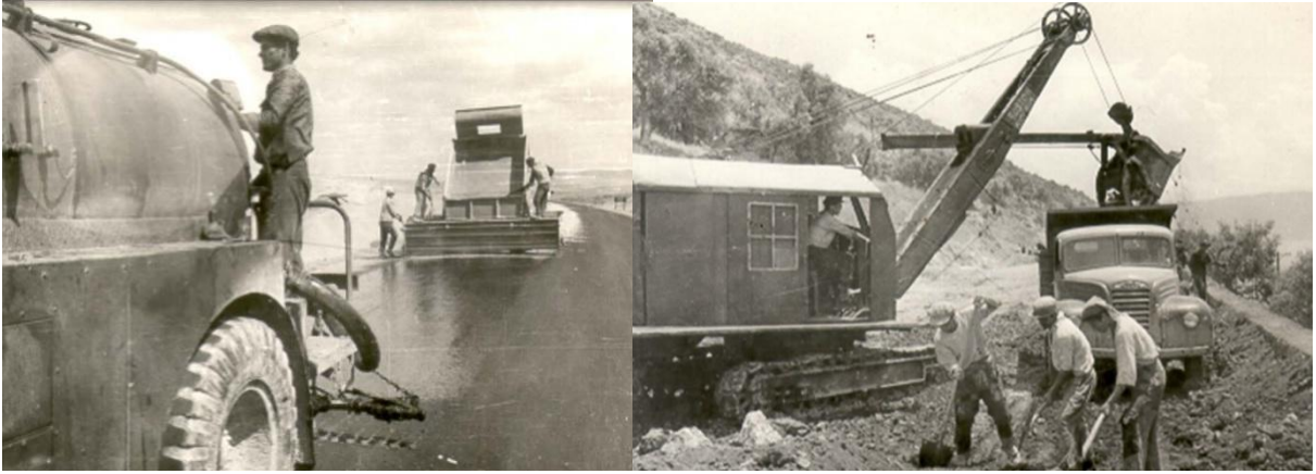
Görsel 6.16: Yol yapım çalışması (1949)
