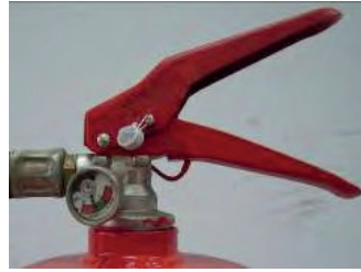
Görsel 2.41: Yangın söndürme cihazı mührü üzerinde olmalıdır.
