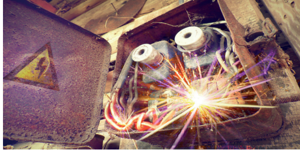
Görsel 1.19: Statik elektrik zararı
