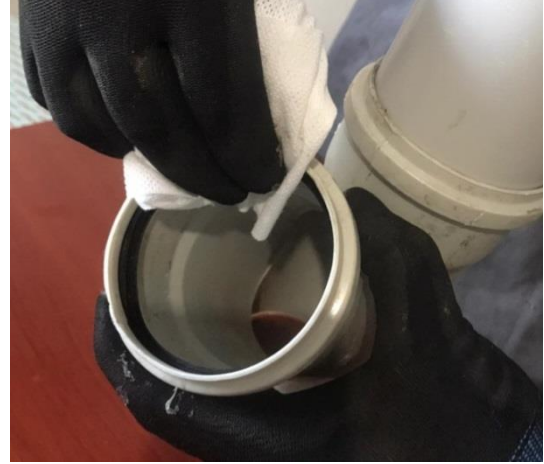
Görsel 5.19: PVC boru conta takılması
