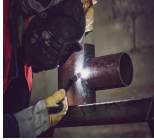
Görsel 13.19: TİG boru kaynağında ek telinin verilmesi
