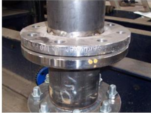
Görsel 12.23: Flanşın puntalanması
