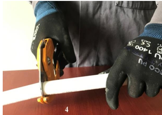
Görsel 5.4: Polipropilen boru kesme aşamaları
