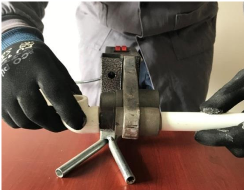
Görsel5.8: PPRC boru kaynağı yapmak
