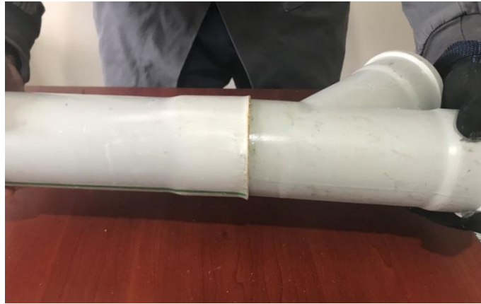
Görsel 5.23: Muf açılmış boruyu birleştirme
