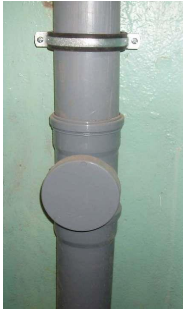
Görsel 5.21: PVC boru dikey birleştirme
