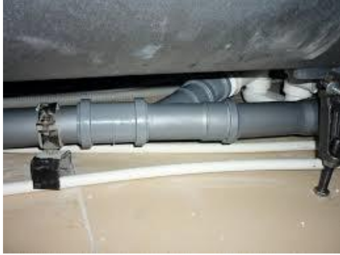
Görsel 5.20: PVC boru yatay birleştirme
