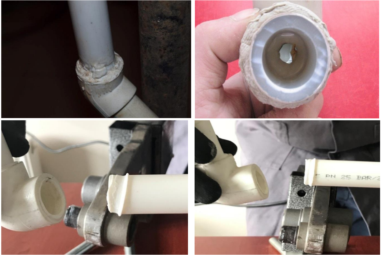
Görsel5.9:PPRCboru kaynak işleminde yapılan hatalar
