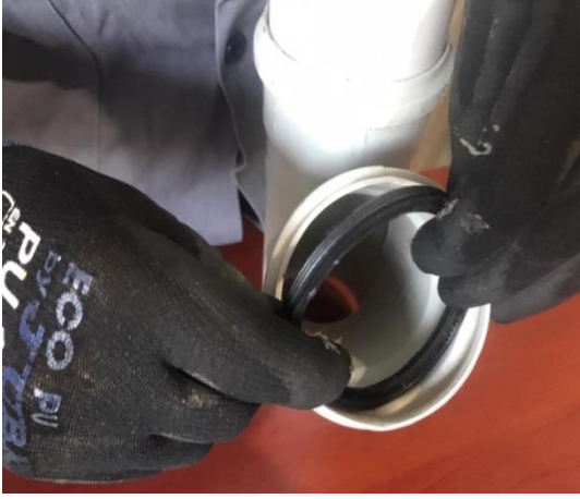
Görsel 5.19: PVC boru conta takılması
