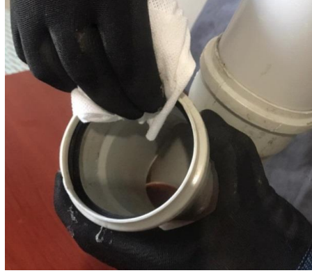
Görsel 5.19: PVC boru conta takılması
