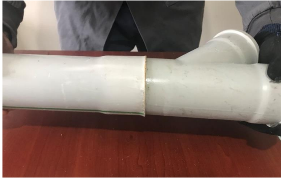
Görsel 5.23: Muf açılmış boruyu birleştirme
