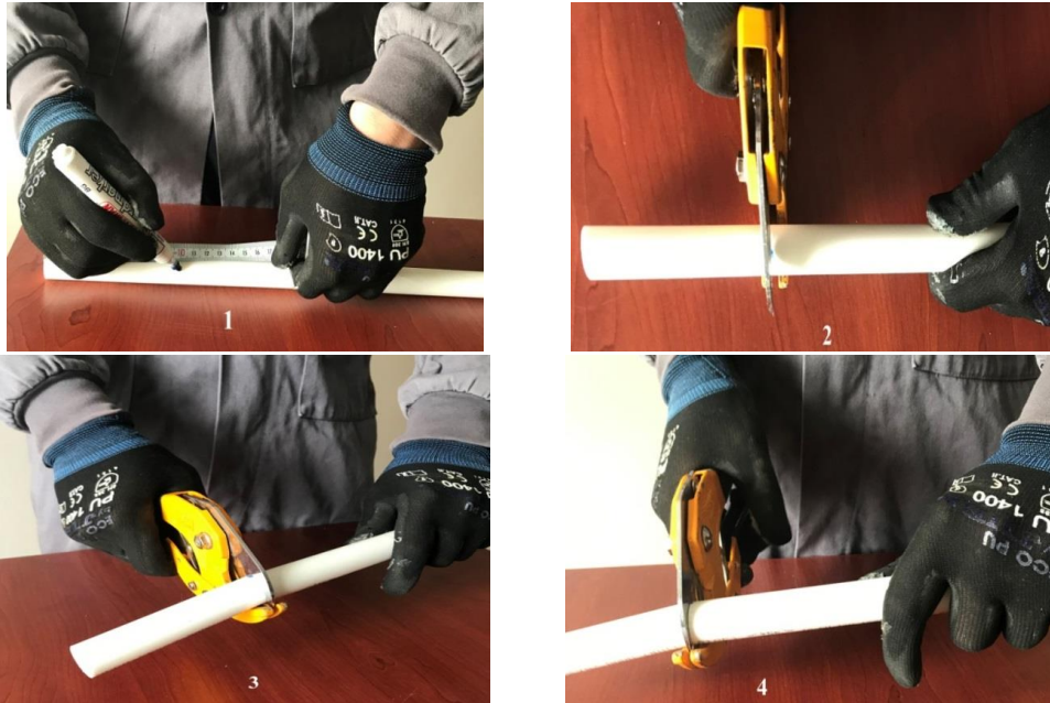
Görsel 5.4: Polipropilen boru kesme aşamaları
