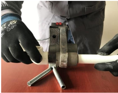
Görsel 5.8: PPRC boru kaynağı yapmak
