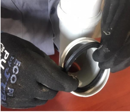
Görsel 5.19: PVC boru conta takılması
