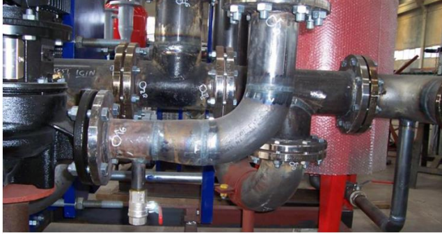
Görsel 12.20:Flanşla birleştirilmiş boru donanımı
