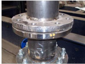
Görsel 12.23:Flanşın puntalanması
