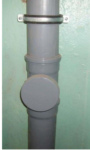
Görsel 5.21: PVC boru dikey birleştirme
