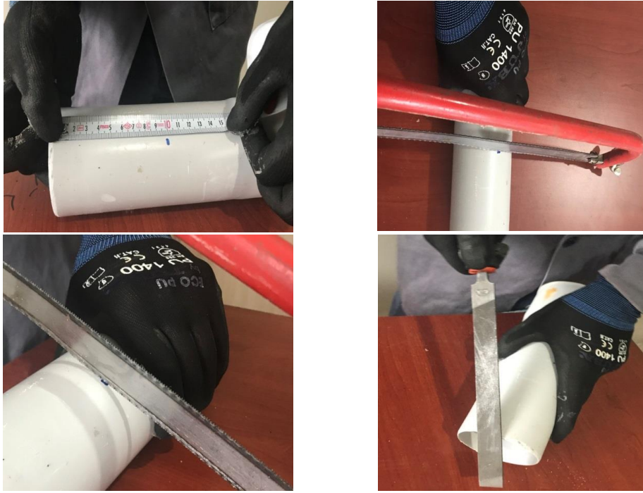
Görsel 5.16: PVC boru kesme ve pah kırma aşamaları
