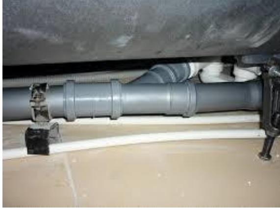
Görsel 5.20: PVC boru yatay birleştirme
