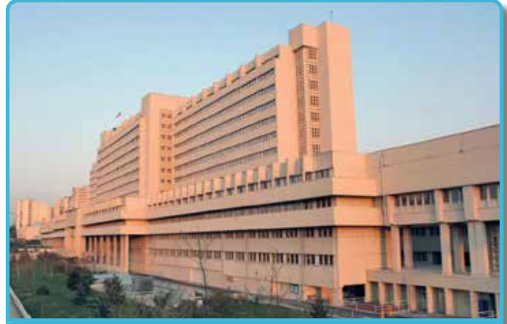
Görsel 3.12: Sayıştay hizmet binası
