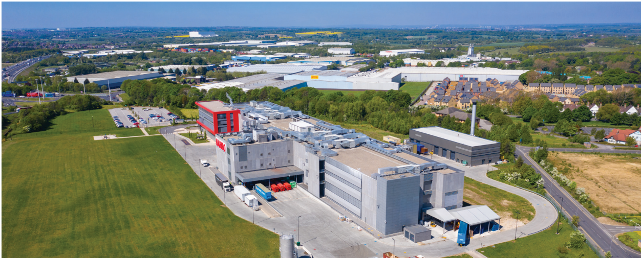
Görsel 1.4: Gıda işletmesi ve çevresi
