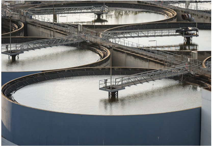
Görsel 3.5: Atıksu arıtma tesisi
