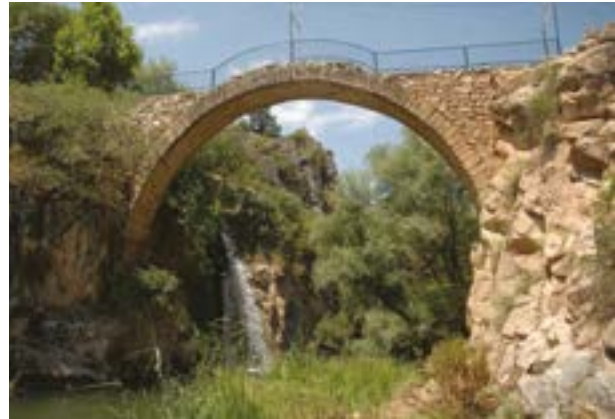
Görsel 8.12: Cılandıras Köprüsü-Uşak
