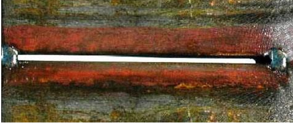
Görsel 6.26: Puntalanan iki parçanın arasındaki mesafe eşit olmalıdır.
