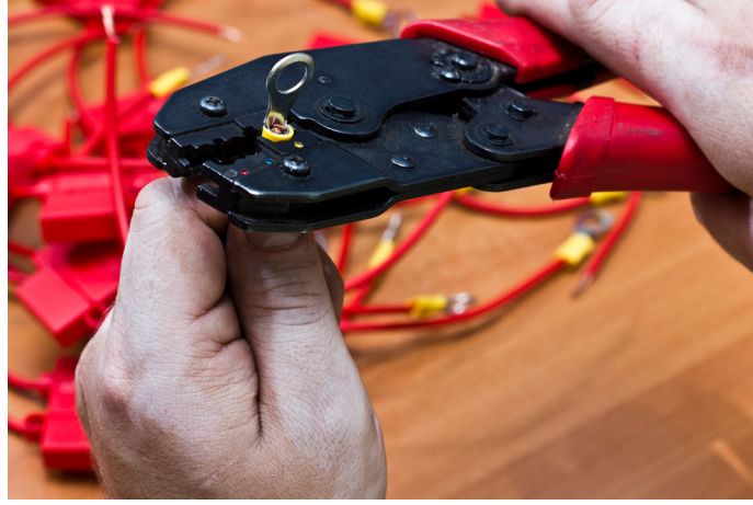
Görsel 5.14: Sıkıştırma aleti ile kablo pabucunun sıkıştırılması
