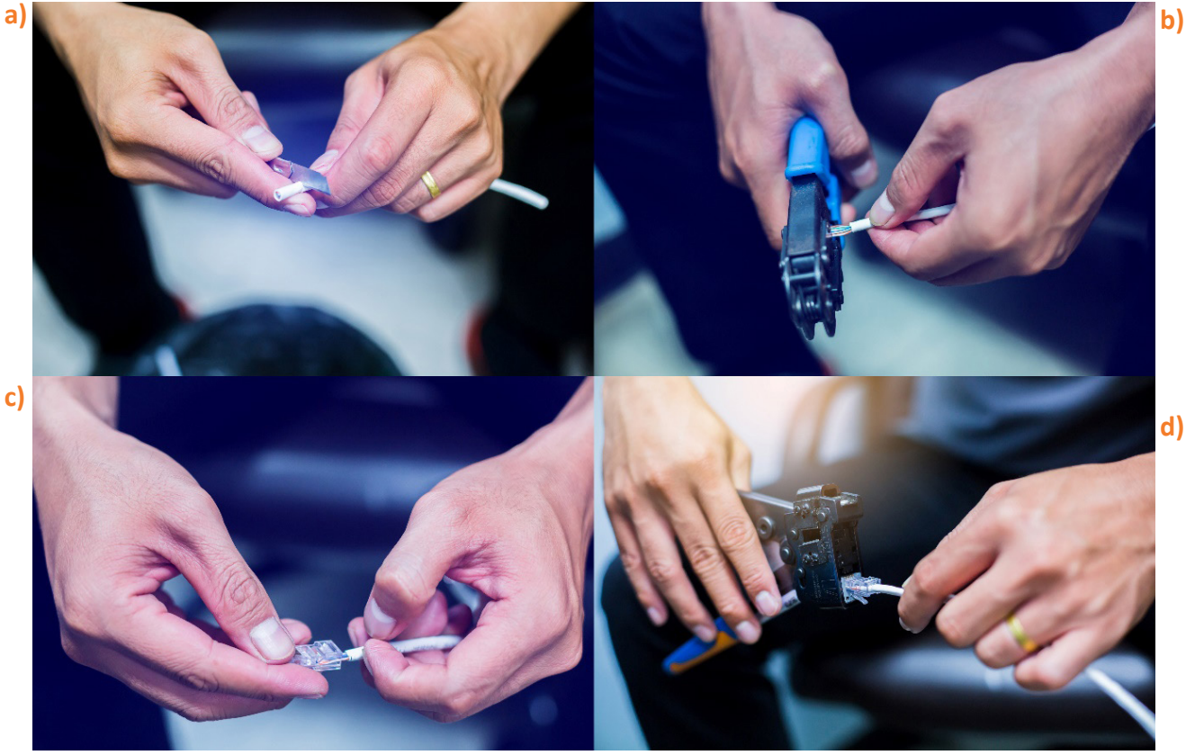
Görsel 5.21: RJ45 soket bağlantısının yapılması
