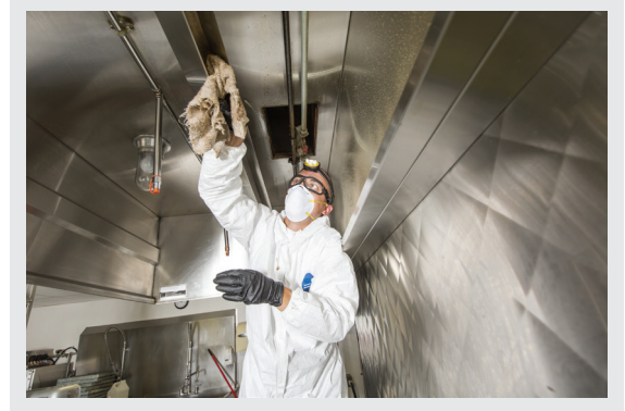
Görsel 2.1.1: Hijyen uygulaması
