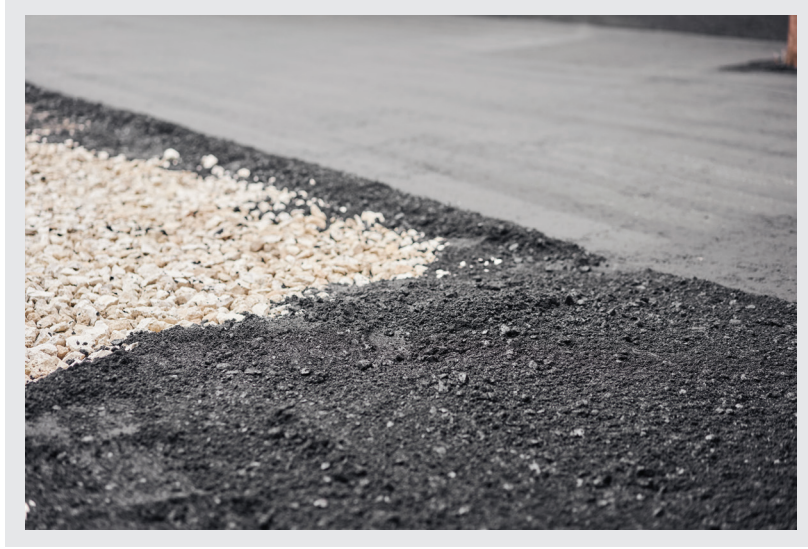
Görsel 9.2.4: Beton zeminler
