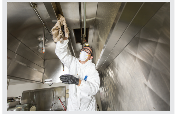
Görsel 2.1.1: Havalandırma temizliği
