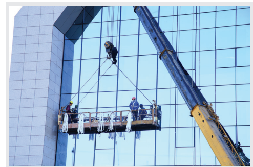
Görsel 9.1.2: Dış cephe cam temizliği
