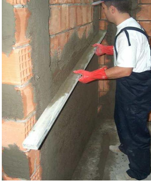
Resim 5.32: Dięer mastarlıkların doldurulması ve mastarla dzeltilmesi
