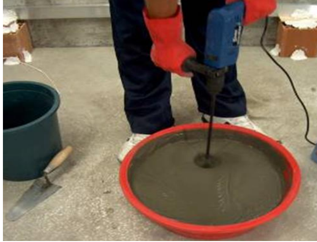
Resim 6.39 Yapıştırıcının mikser ile karıştırılması
