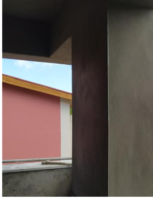
Resim 5.44: Köşelere profili takılması
