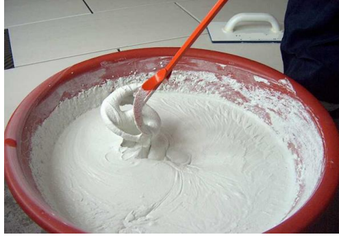
Resim 6.71: Derz harcı mikser ile karıştırılması
