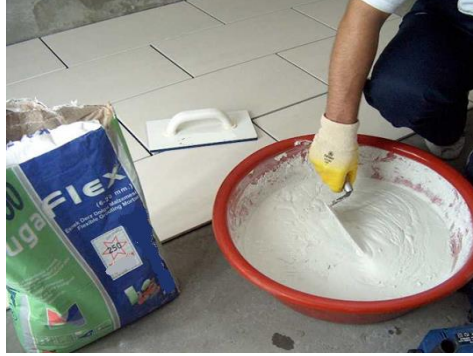
Resim 6.70: Derz dolgu harcının mala ile karıştırılması
