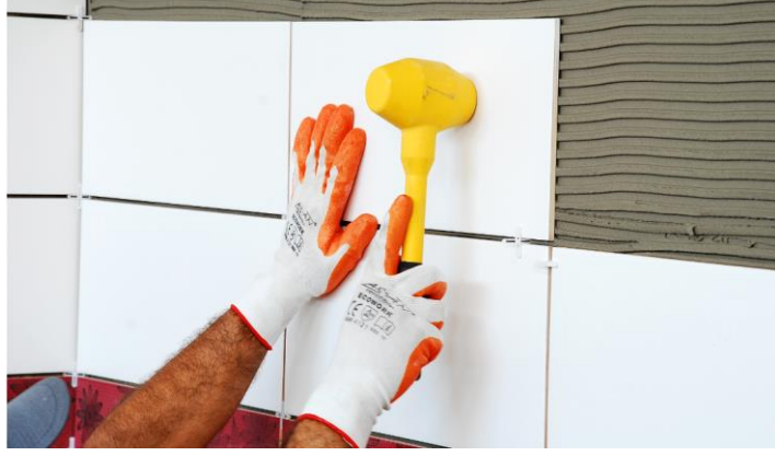
Resim 6.52: Seramiklerin tokmakla sıkıştırılması
