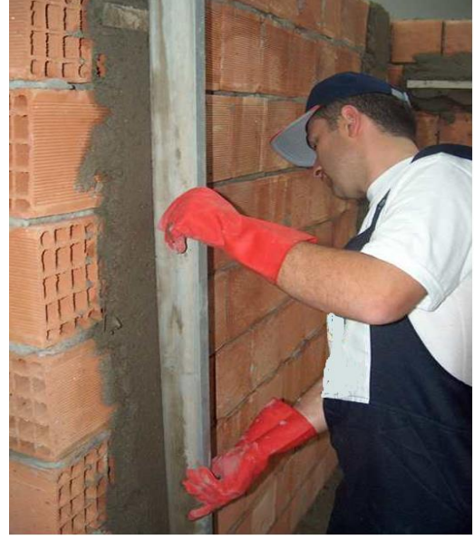
Resim 5.29: Masterlık ıtaları arası harların masterla dűzeltilmesi
