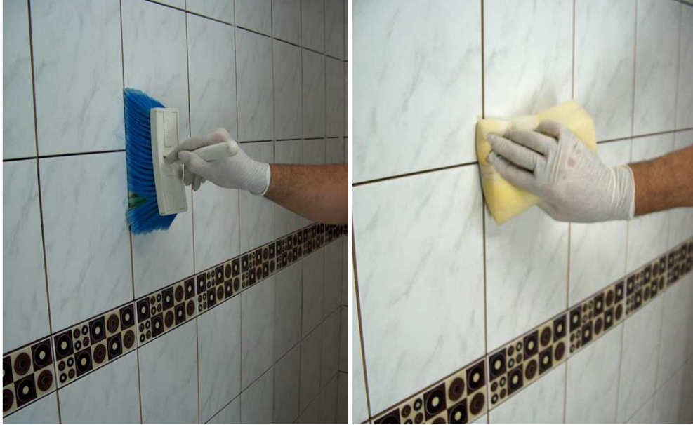
Resim 6.68: Derz aralarının temizlenmesi
