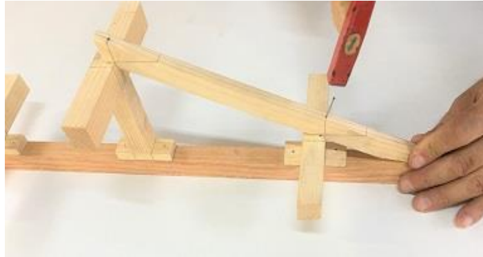
Resim 2.23: Merteklerin montajı
