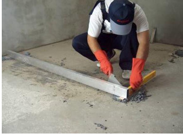
Resim 6.75(a): Masterlık çıtalarının yerleştirilmesi
