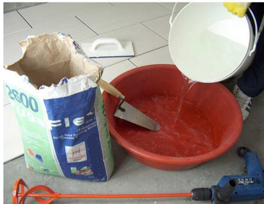
Resim 6.69: Derz harcı suyunun ayarlanması
