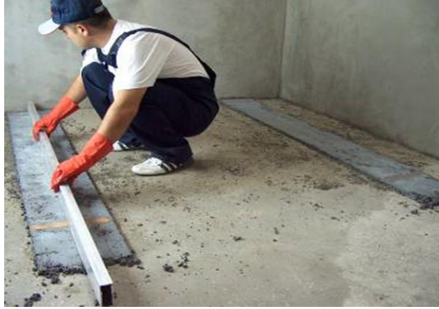
Resim 6.75(b): Masterlık çıtalarının masterlıkların oluşturulması
