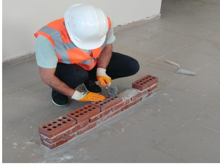
Resim 4.60: 3. sıranın iki tam tuğla arasına diğer tam tuğlaların yerleştirilmesi
