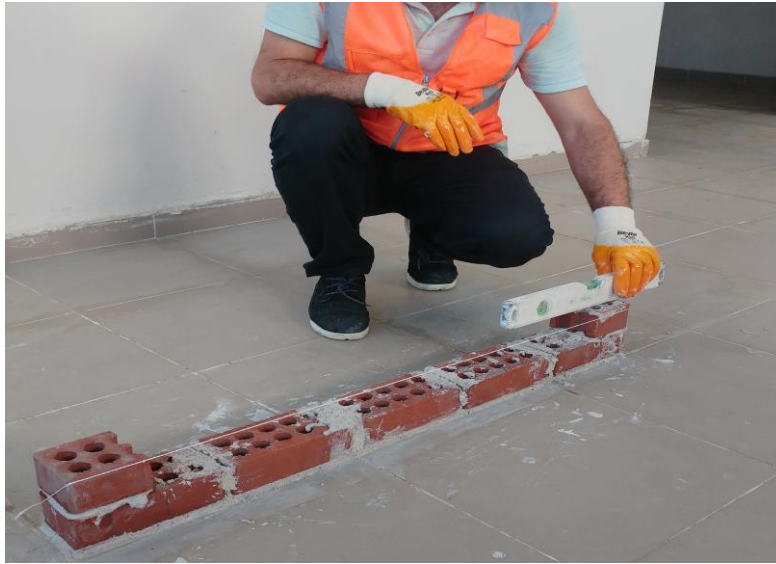
Resim 4.57: 2. Sıranın diğer yarım tuğlasının yerleştirilmesi ve ip çekilerek teraziye alınması
