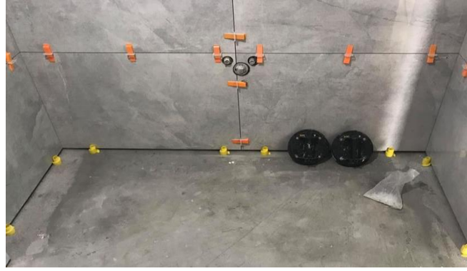
Resim 6.55: Derzlere seviye tespit aparatlarının yerleştirilmesi
