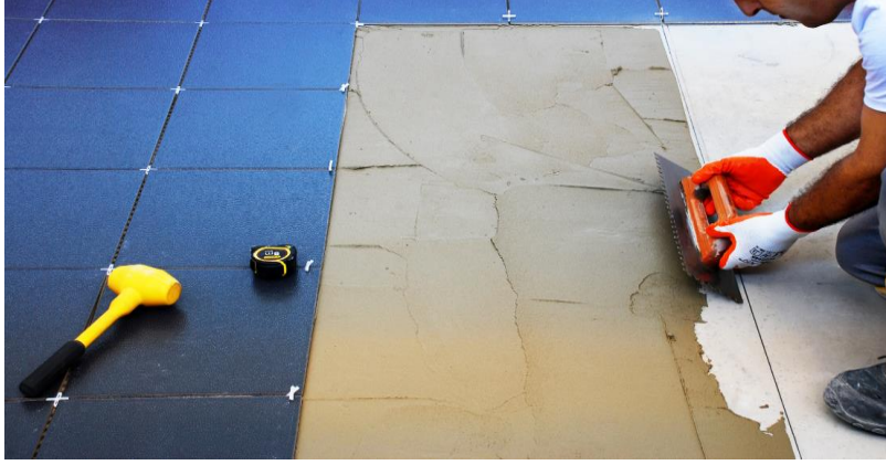
Resim 6.41(a): Harcı yüzeye uygulama
