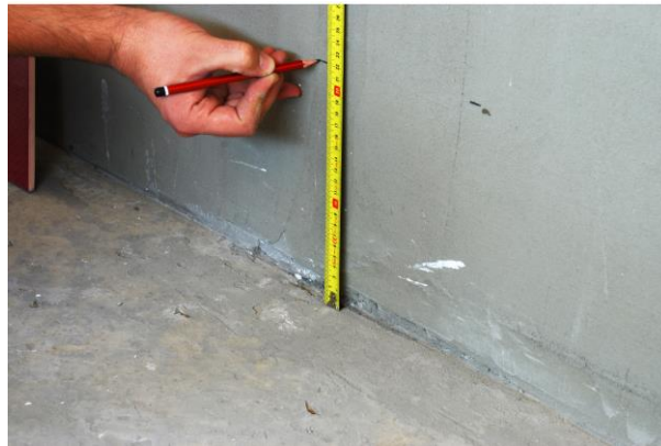
Resim 6.31: Mastar seviyesi hesaplama ve işaretleme
