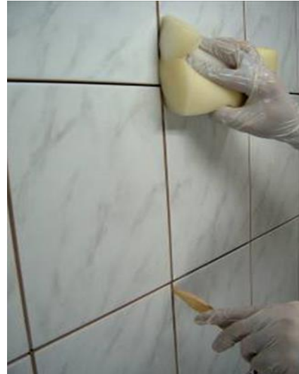
Resim 6.67: Derz aralarının temizlenmesi
