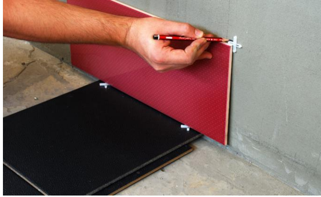
Resim 6. 32: Mastar seviyesi hesaplama ve işaretleme
