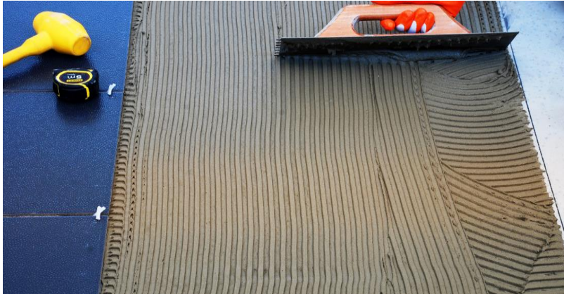
Resim 6.41(b): Harcın taraklanması
