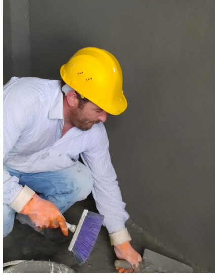
Resim 5.46: Yere dökülen harçların temizlenmesi
