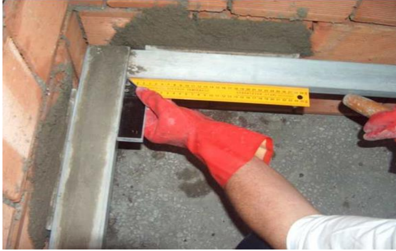
Resim 5.27: Dik birleşen duvarlarda masterlık çitalarının gönyeye alınması
