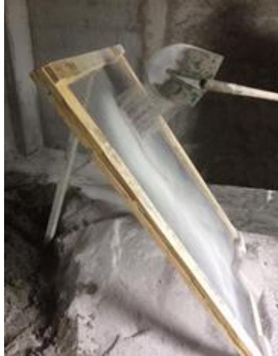
Resim 4.38: Harç kumunun elenmesi
