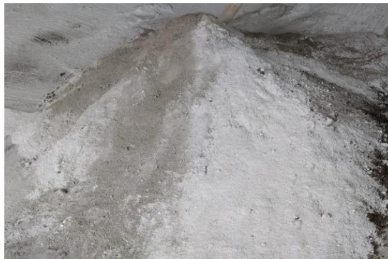
Resim 4.41: Kumun üzerine çimento ve kirecin katılması
