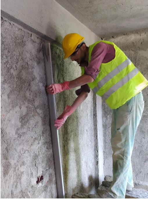
Resim 5.36: Kaba sıva yüzeyinin master ile düzgünlük kontrolü
