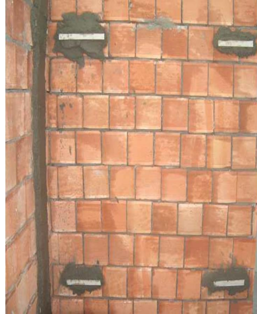
Resim 5.26: Masterlık ıtalalarının yerleştirilmiş hali
