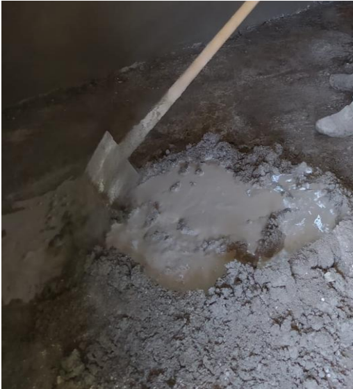
a) Harcın karıştırılması
