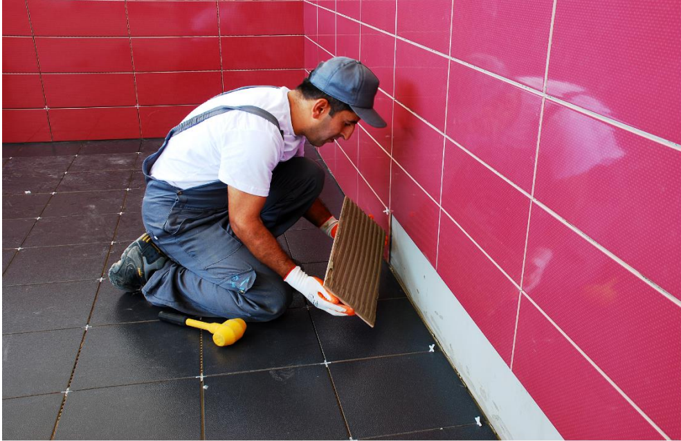
Resim 6.64: Birinci sıra seramiklerinin yağlama yöntemiyle harçlanması
