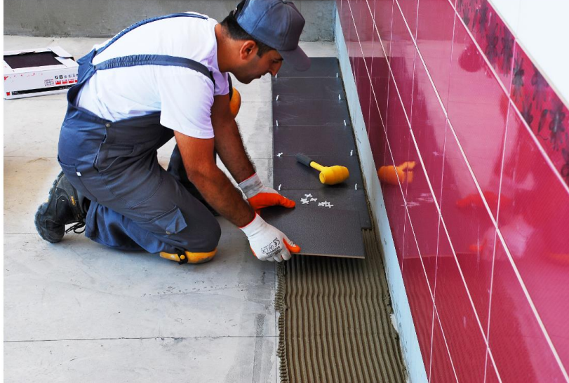
Resim 6.85: Birinci sıra seramik yer karosunun uygulanması
