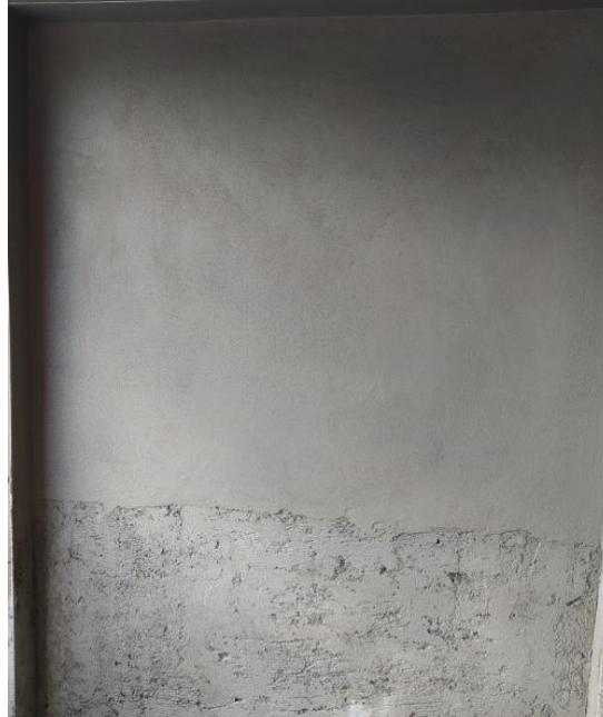
Resim 5.41: Yüksek duvarlarda ince sıva uygulaması
