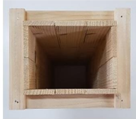
Resim 3.18: Montajı tamamlanmış ahşap dikdörtgen kesitli kolon kalıbı
