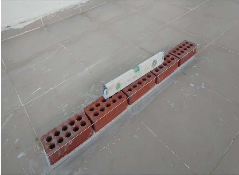
Resim 4.55: Birinci sıranın örülmesi ve düzgünlük kontrolü
