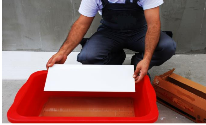
Resim 6. 28: Seramik karoların ıslatılması
