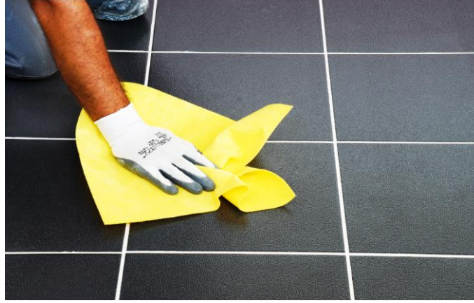
Resim 6.96: Yüzeyin kuru bezle temizlenmesi
