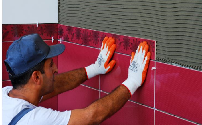
Resim 6.53: Bordür (dekor) seramiklerinin yapıştırılması
