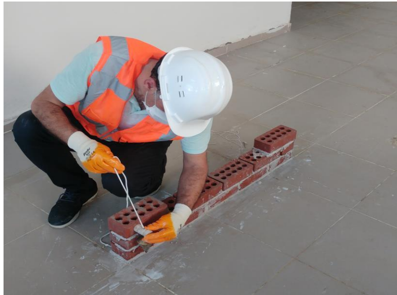
Resim 4.59: 3. Sıranın iki ucuna tam tuğla konulması ve şakülle diklik kontrolü
