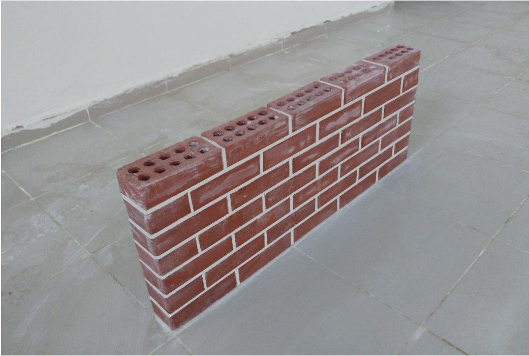
Resim 4.62: Düz sıralı normal tuğla duvar
