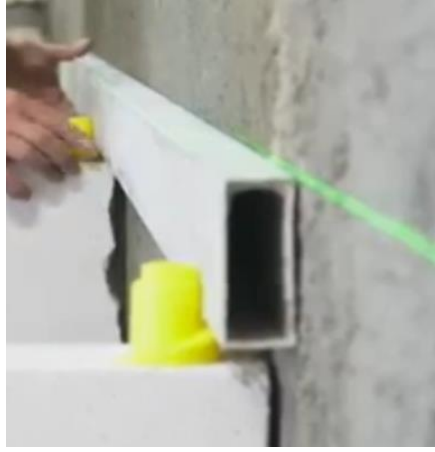
Resim 6.34: Masterların Lazer terazi yardımıyla blok ve akıllı takoz ile ayarlanması
