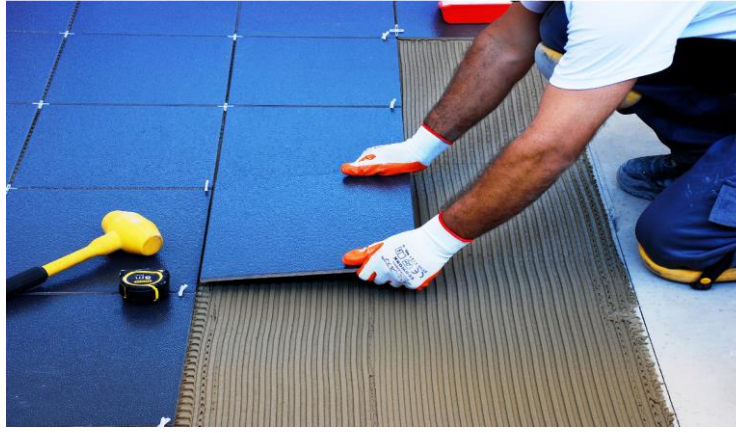
Resim 6.86(a): Seramiklerin el ile yerleştirilmesi
