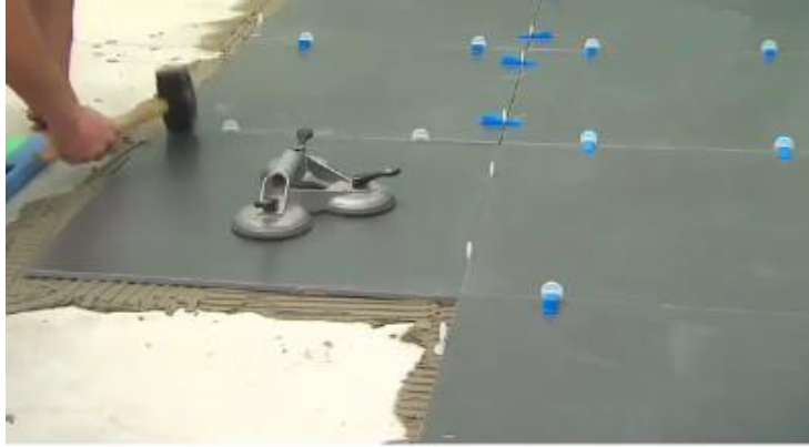
Resim 6.86(b): Seramiklerin vantuz ile yerleştirilmesi
