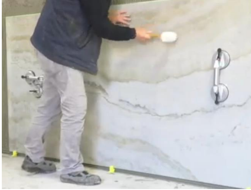
Resim 6.50: Büyük ebatlı seramiklerin vantuz yardımıyla yerleştirilmesi
