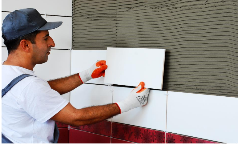
Resim 6.48: Seramik karoların yerleştirilmesi
