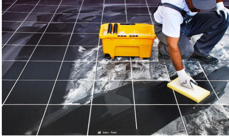
Resim 6.94: Derzlerin sünger mala ile temizlenmesi
