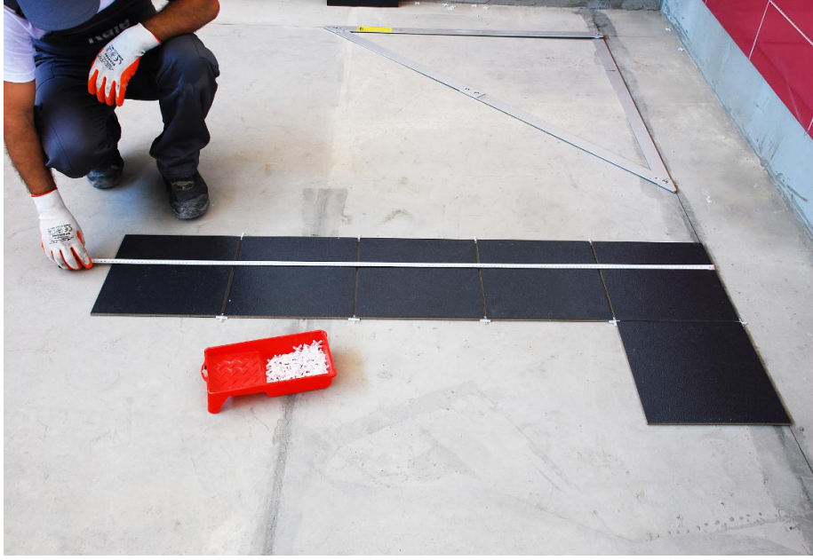
Resim 6.80: Zemin gönyesini ayarlanması
