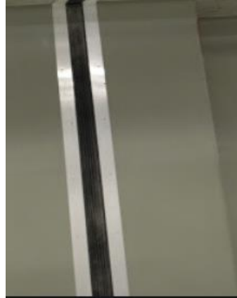
Resim 5.47: Dilatasyon derzi profili
