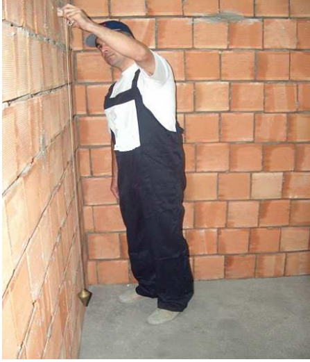
Resim 5.20: Yüzeyin şakül ile kontrolü
