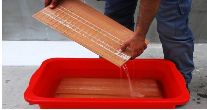
Resim 6. 29: Islatılan seramik karoların çıkartılması
