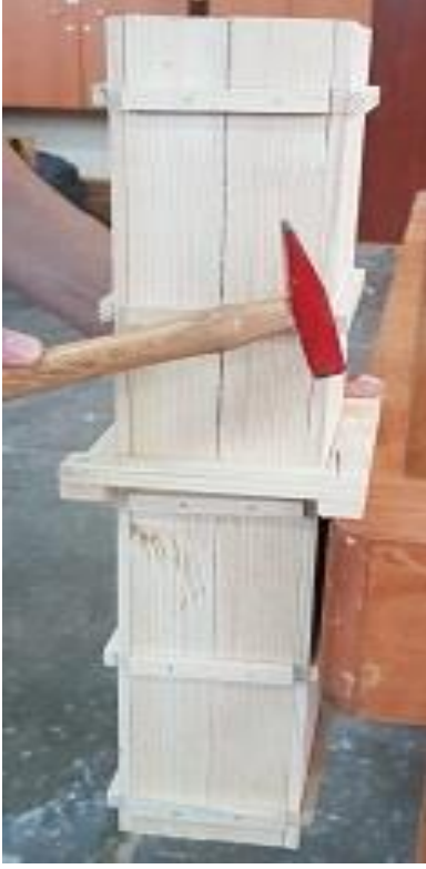
Resim 3.17: Kuşak montajı
