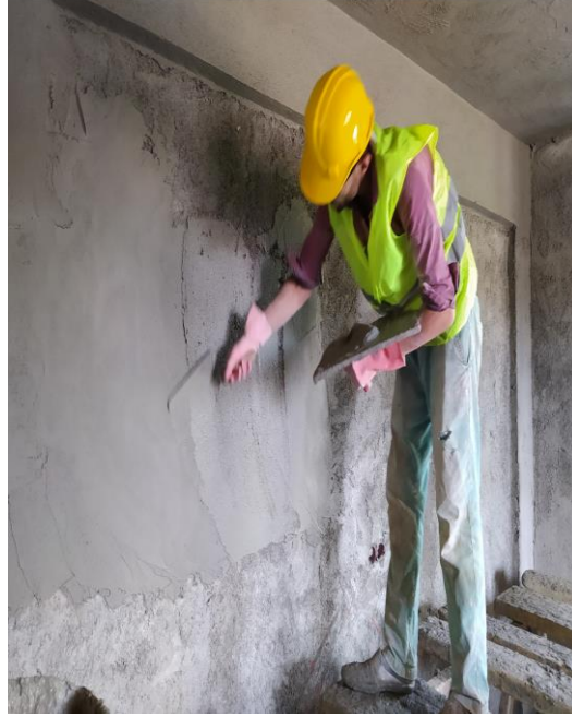
Resim 5.40: Sıva yüzeyinin mala ile düzeltilmesi
