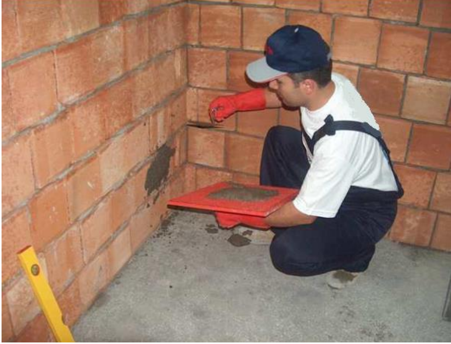
Resim 5.24: Duvar yüzeyindeki masterlık ıtası harcı atılması
