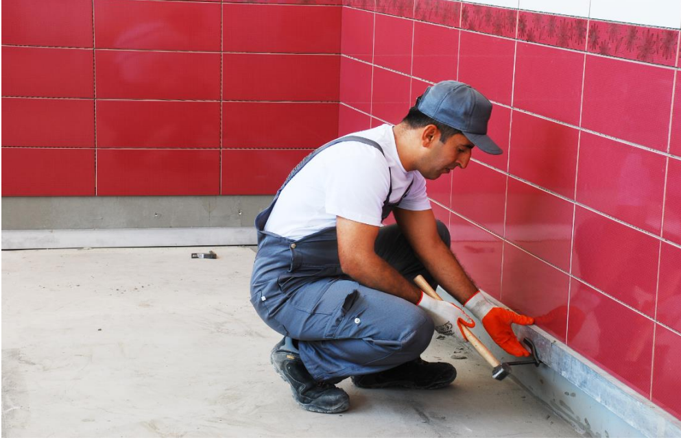
Resim 6.63: Kaplama sonrası masterların sökülmesi
