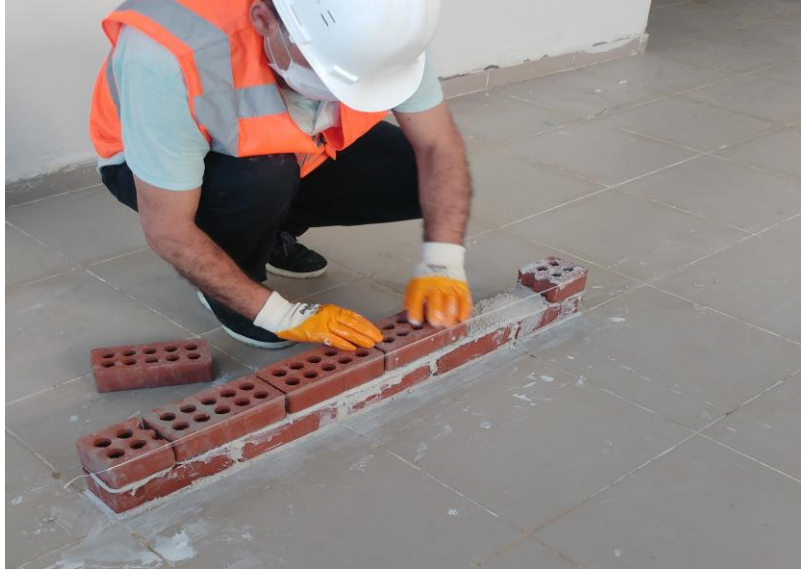
Resim 4.58: İki yarım tuğla arasına tam tuğlaların örülmesi
