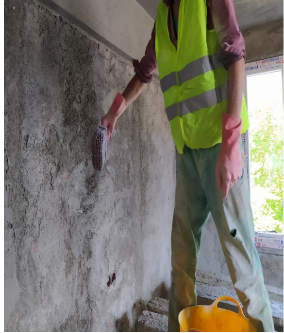
Resim 5.37: Yüzeyin nemlendirilmesi
