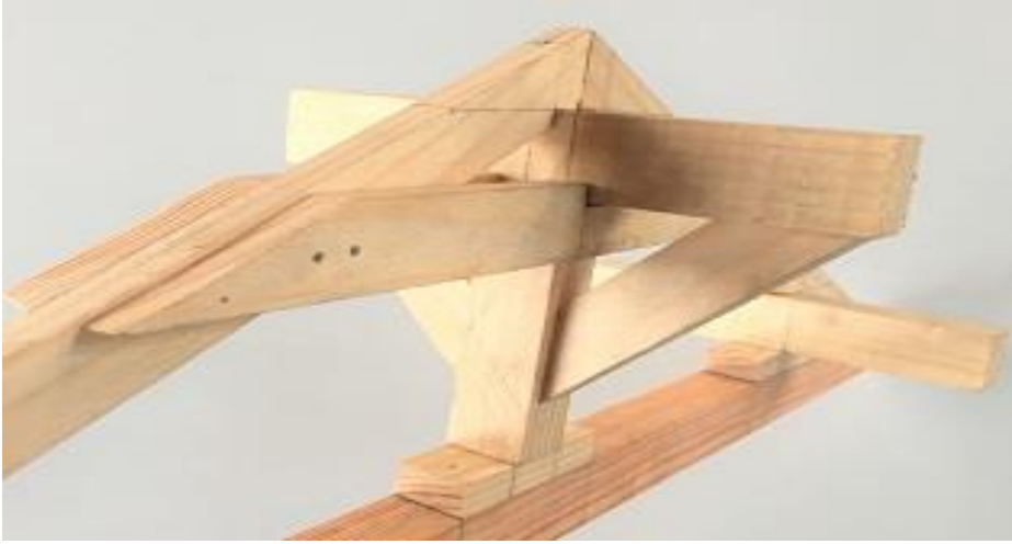
Resim 2.29: Ahşap çatı makası elamanları montaj
