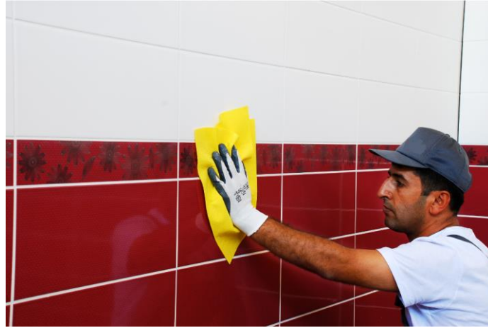
Resim 6.74: Yüzeyin kurulanması
