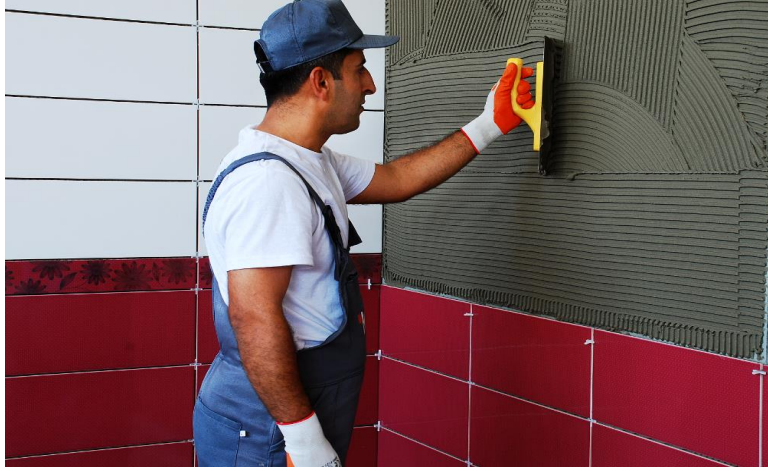
Resim 6.46: Yüzeyin taraklanması
