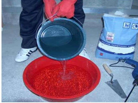
Resim 6.37: Harç suyu hazırlama
