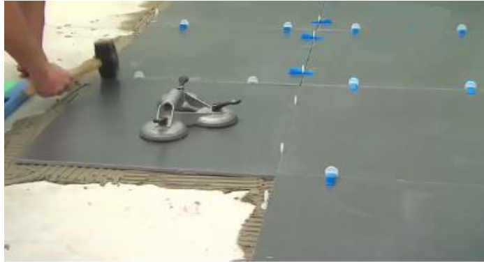
Resim 6.90: Derz tesviye artılarının yerleştirilmesi
