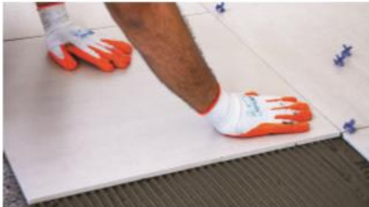
Resim 6.43(c): Kombine yöntemi yapıştırma aşamaları
