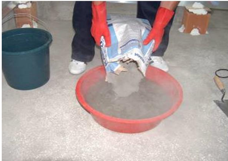
Resim 6.38: Yapıştırıcının suya katılması
