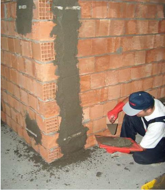
Resim 5.28: Masterlık ıtaları arası harla doldurulması
