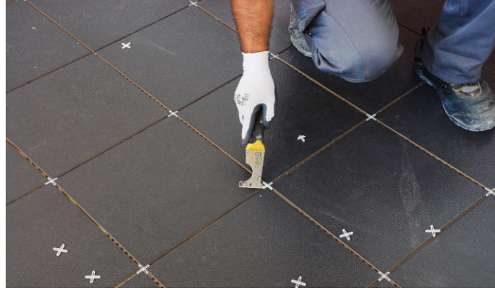
Resim 6.91: Derz aralarının temizlenmesi
