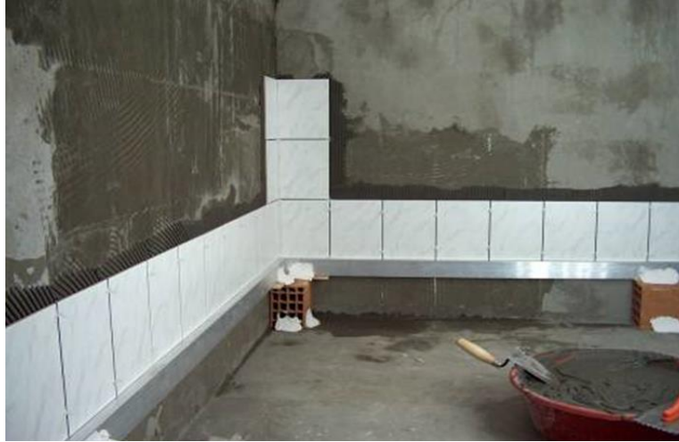
Resim 6.47: Birinci sıra ve köşe seramiklerinin yerleştirilmesi
