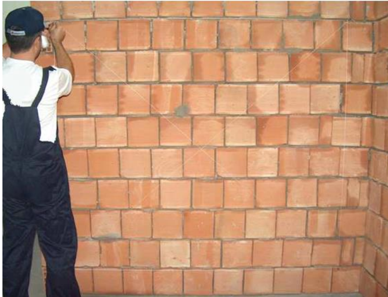
Resim 5.22: Yüzeyin ip ile kontrolü
