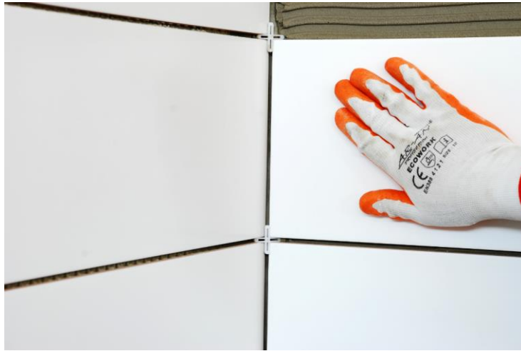
Resim 6.60: Köşe birleşen iki duvar kaplama arası derz boşluğu
