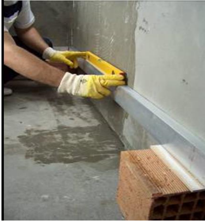
(a) (b) Resim 6.35(a, b): Masterlıkların blok ve seramik parçalarıyla ayarlanması
