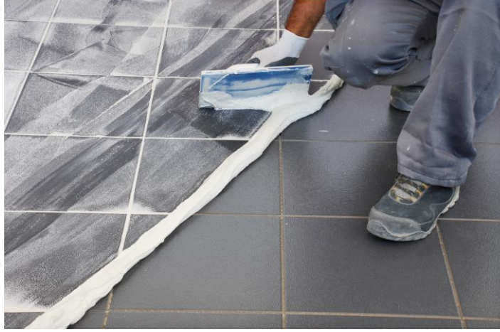
Resim 6.93: Plastik kauçuk esashı mala ile derzlerin doldurulması
