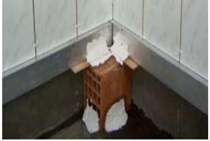
(a) (b) Resim 6.35(a, b): Masterlıkların blok ve seramik parçalarıyla ayarlanması
