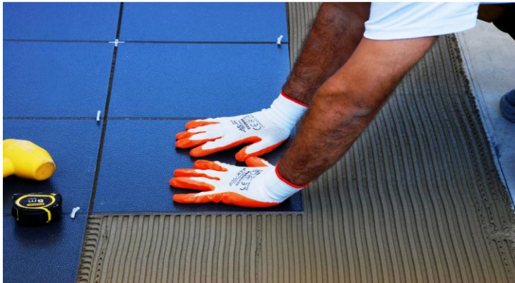
Resim 6.87: Seramiklerin elle sıkıştırılması
