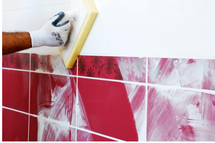
Resim 6.73: Derz dolgunun yüzeyden temizlenmesi
