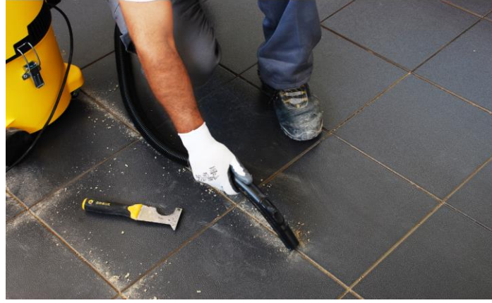
Resim 6. 92: Derz aralarının elektrikli süpürge ile temizlenmesi
