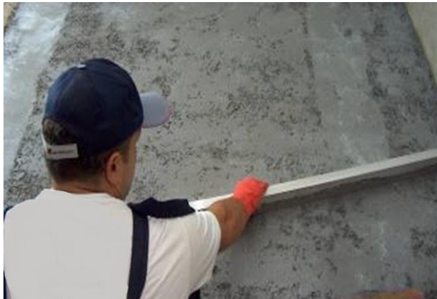
Resim 6.76: Harç ile doldurulan masterlık aralarının masterla düzeltilmesi
