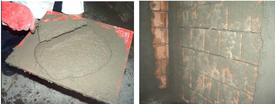
Resim 5.31: Diğer Masterlıkların arasına serpmeye sıva atılması
