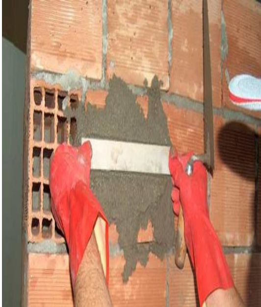
Resim 5.25: Masterlık ıtalalarının yerleştirilmesi
