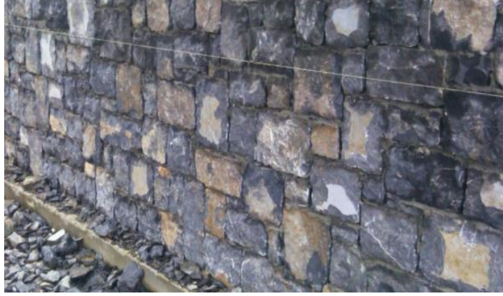
Resim 4.8: Kesme taş ile örülen bahçe duvarı
