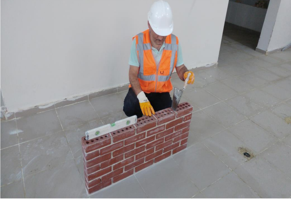
Resim 4.61: Tuğla duvar sıralarının örülmesi ve düzgünlük kontrolü
