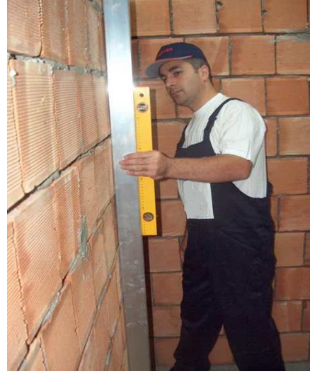
Resim 5.21: Yüzeyin mastar ile kontrolü
