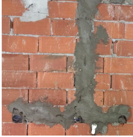
Resim 5.23: Duvar yüzeyindeki boşlukların doldurulması
