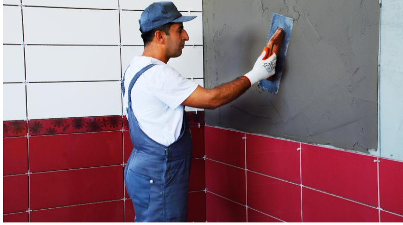
Resim 6.44: Yapıştırıcının yüzeye sürülmesi
