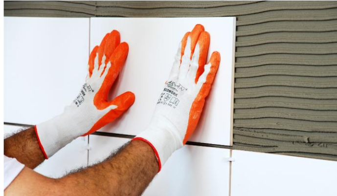
Resim 6.51: Seramiklerin serbest elle sıkıştırılması
