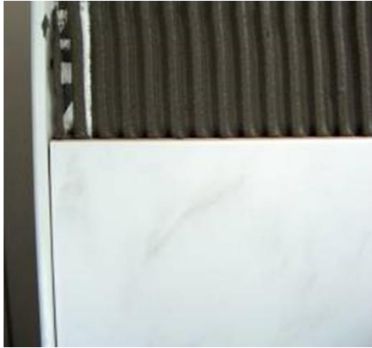
Resim 6.49: Köşe çitasının yerleştirilmesi
