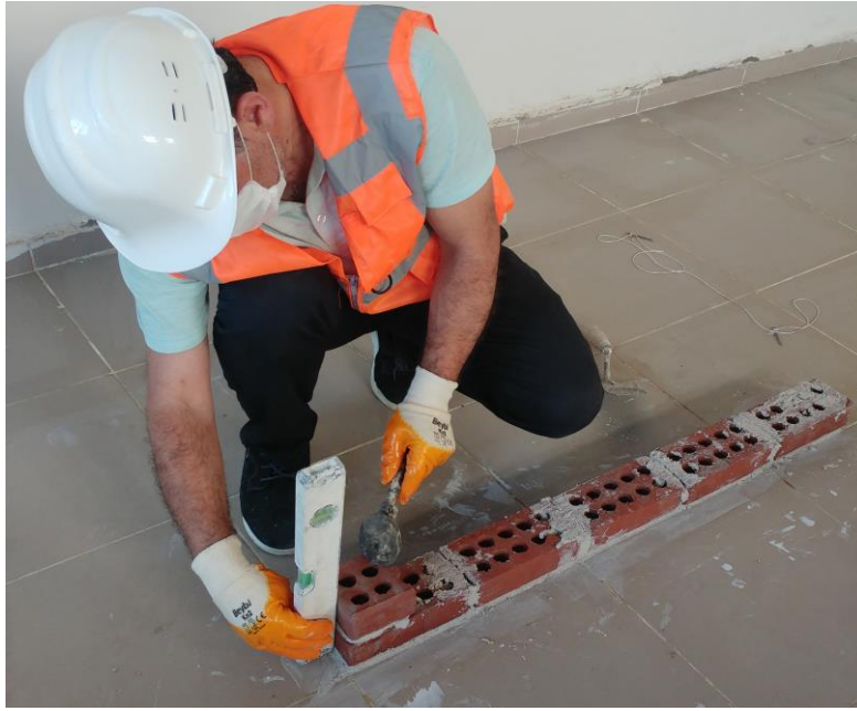
Resim 4.56: 2. sıranın başlangıcına ilk yarım tuğlanın yerleştirilmesi
