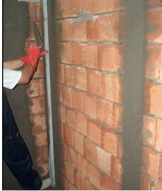
Resim 5.30: Dięer Masterlıkların yapılması
