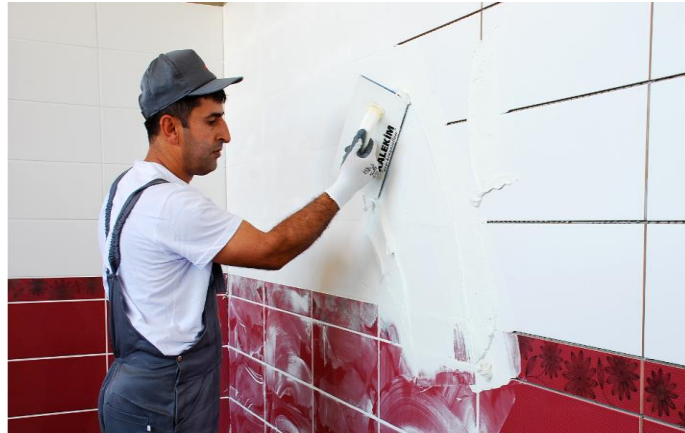
Resim 6.72: Derz dolgunun yüzeye uygulanması
