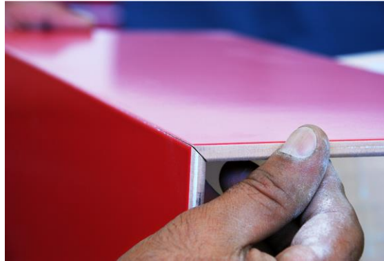
Resim 6.62: İç köşe birleşim profil yerleştirilmesi
