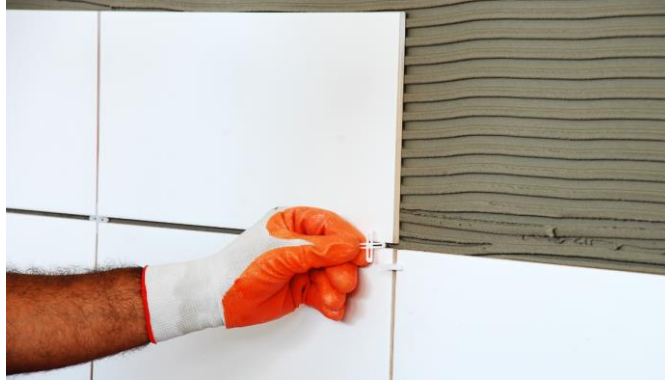
Resim 6.54: Derz artılarının yerleştirilmesi
