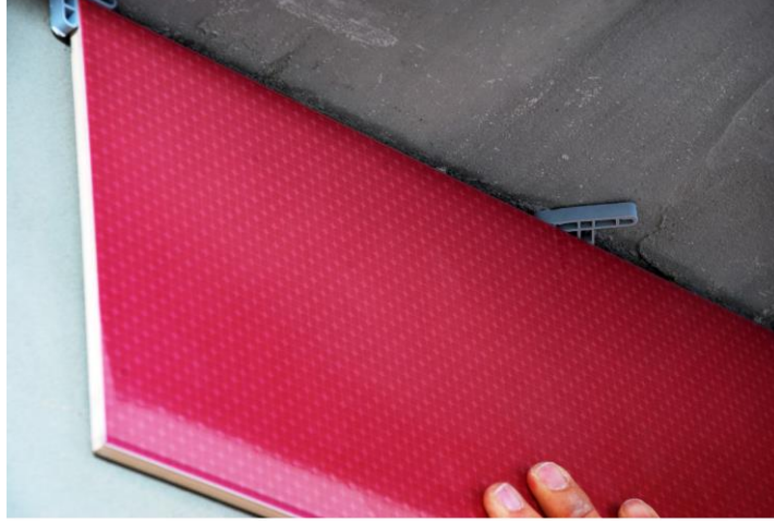
Resim 6.59: Tavan ile kaplama arası derz boşluğu
