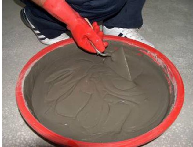
Resim 6.40: Harcın olgunlaştırılması
