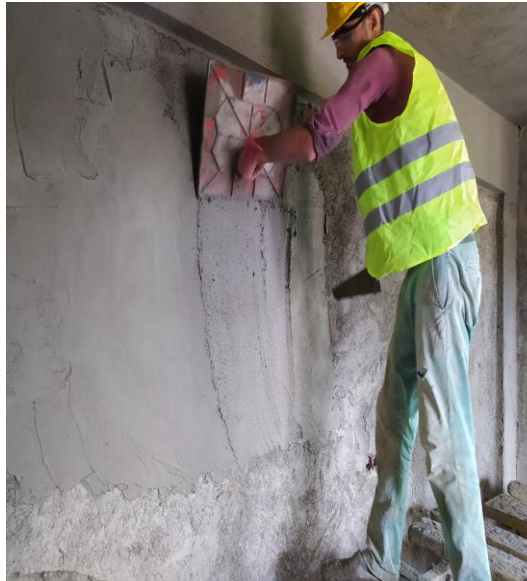
Resim 5.39: Sıva harcının sıvacı küreği veya tahta mala ile yüzeye sürülmesi
