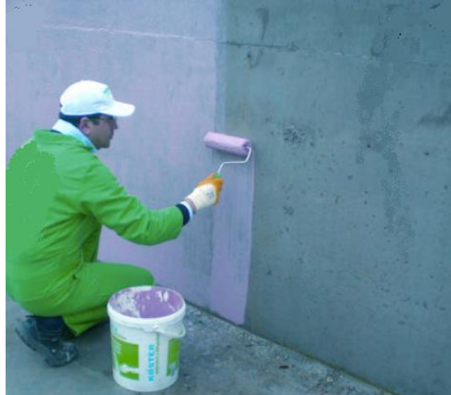
Resim 5.17: Betonarme yüzeylere astar sürülmesi
