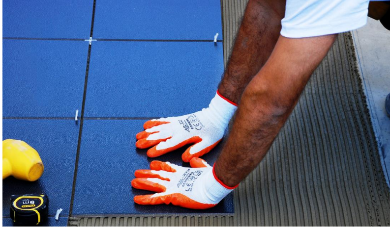
Resim 6.41(c): Taraklama yöntemi ile yapıştırma aşamaları
