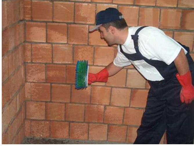
Resim 5.18: Yüzeyin fırça ile nemlendirilmesi
