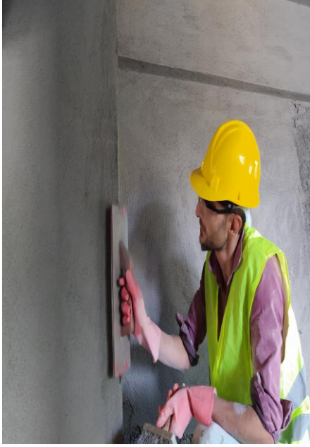
Resim 5.43: Köşelere pah kırılması
