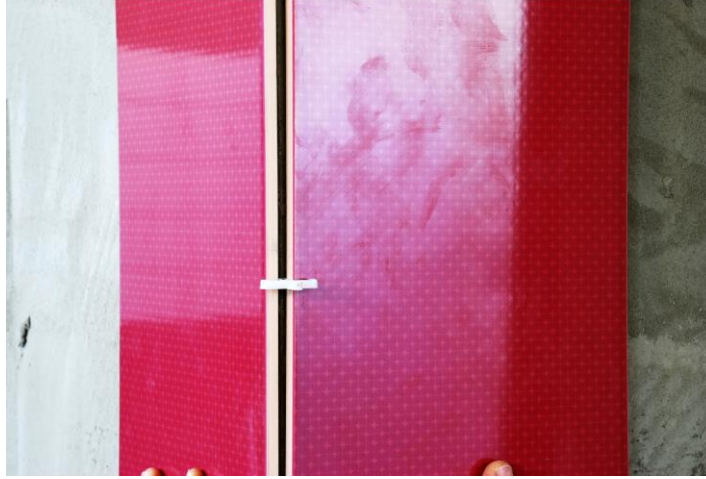
Resim 6.61: Dış köşe birleşim arası derz boşluğu
