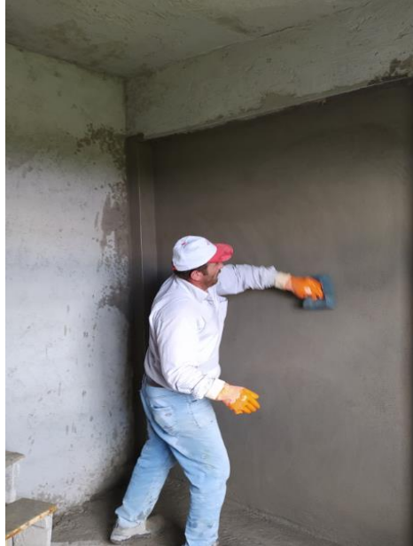
Resim 5.45: Yüzeyin sünger ile temizlenmesi
