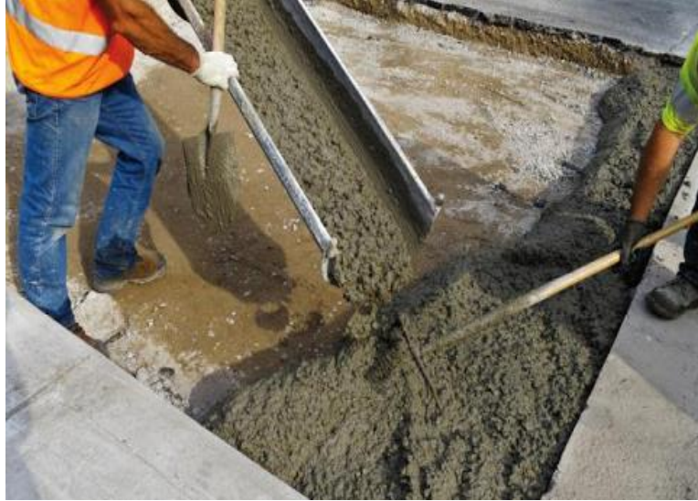
Resim 4.12: Beton ve dökümü
