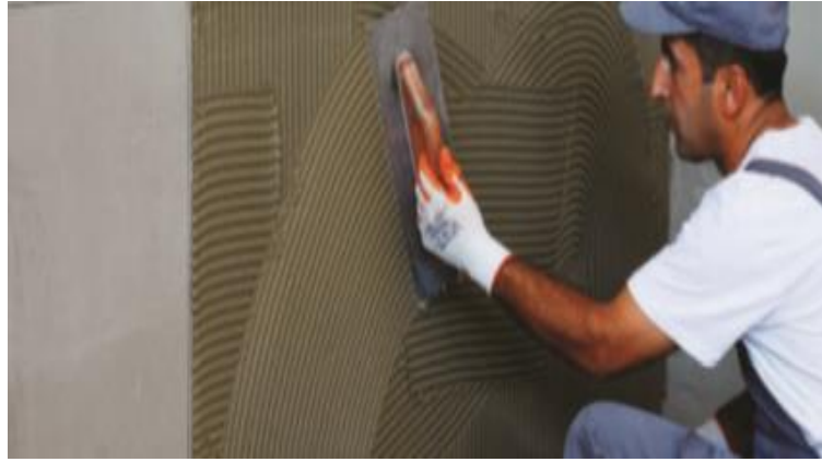
Resim 6.45: Yapıştırıcının yüzeyde dairesel olarak taraklanması
