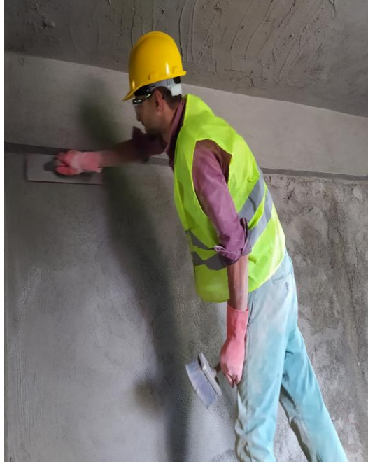
Resim 5.42: Yüzeyin perdahlanması
