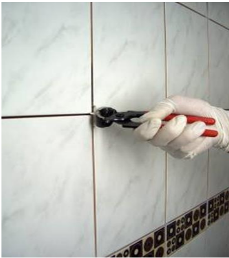
Resim 6.66: Derz artılarının temizlenmesi
