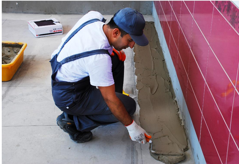
Resim 6.83: Yapıştırıcının yüzeye uygulanması
