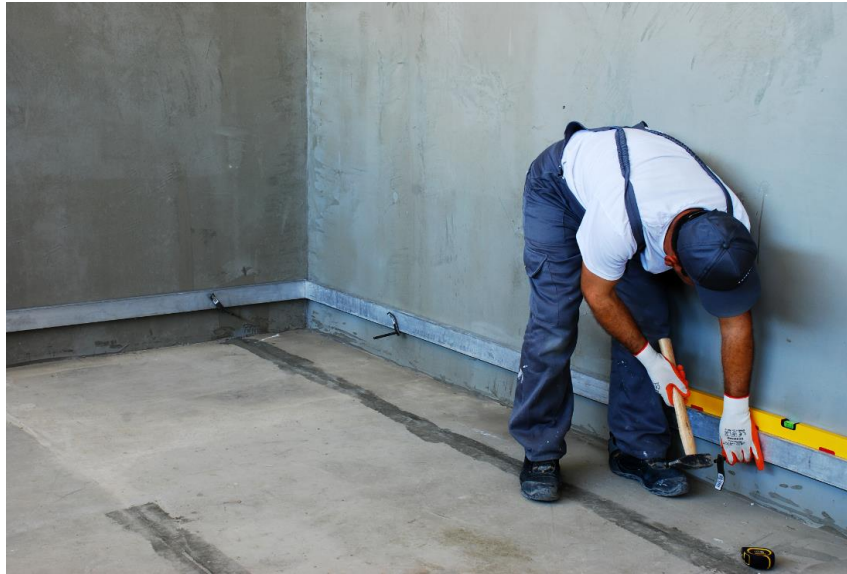
Resim 6.33: Mastar kelepçesi ile mastar bağlama
